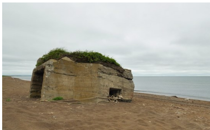
Японский дот на Сахалине. Современный вид
