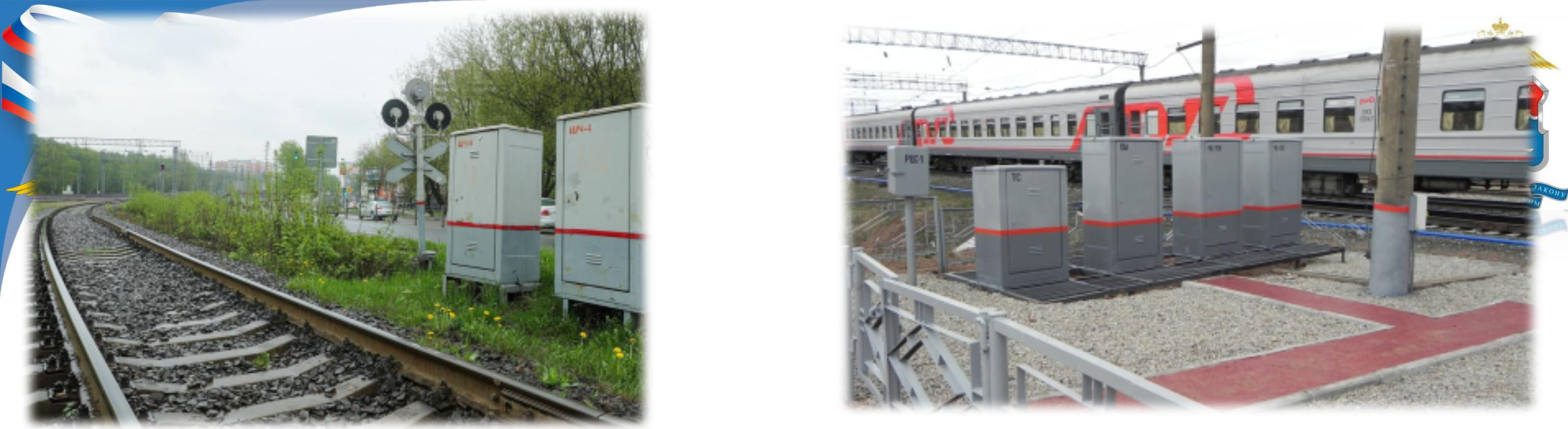
На железной дороге релейные шкафы обычно устанавливают на перегонах или в границах станции. В таких шкафах с достаточно серьёзной защитой от проникновения посторонних, находится аппаратура систем железнодорожной автоматики и телемеханики, помогающая следить за движением поездов на конкретном перегоне.
