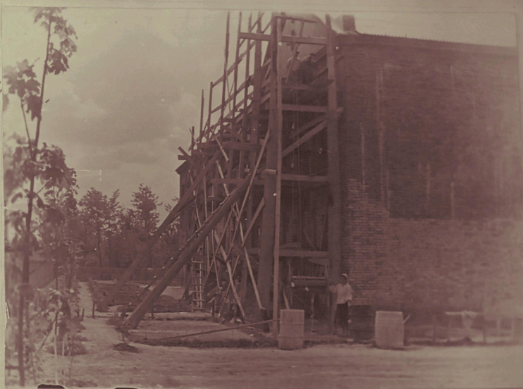
Ф.-1. Внешняя штукатурка здания в июне 1956г.
