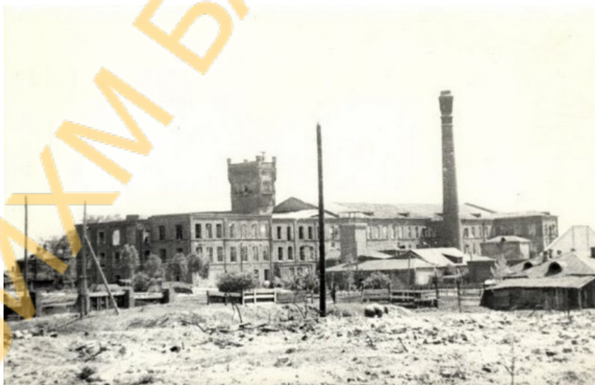
Саввинская фабрика после пожара в 1942 году. Фотография из краеведческого музея г. Железнодорожного.
