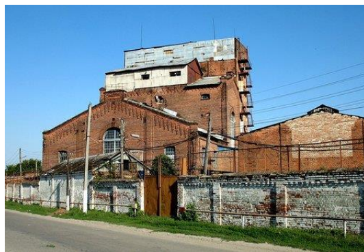
Завод в 2016 год. Не работает.
