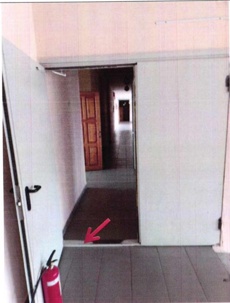
Фото № 15. Дверь по пути движения. Порог в дверном проёме. Дверной проем контрастно не маркирован
