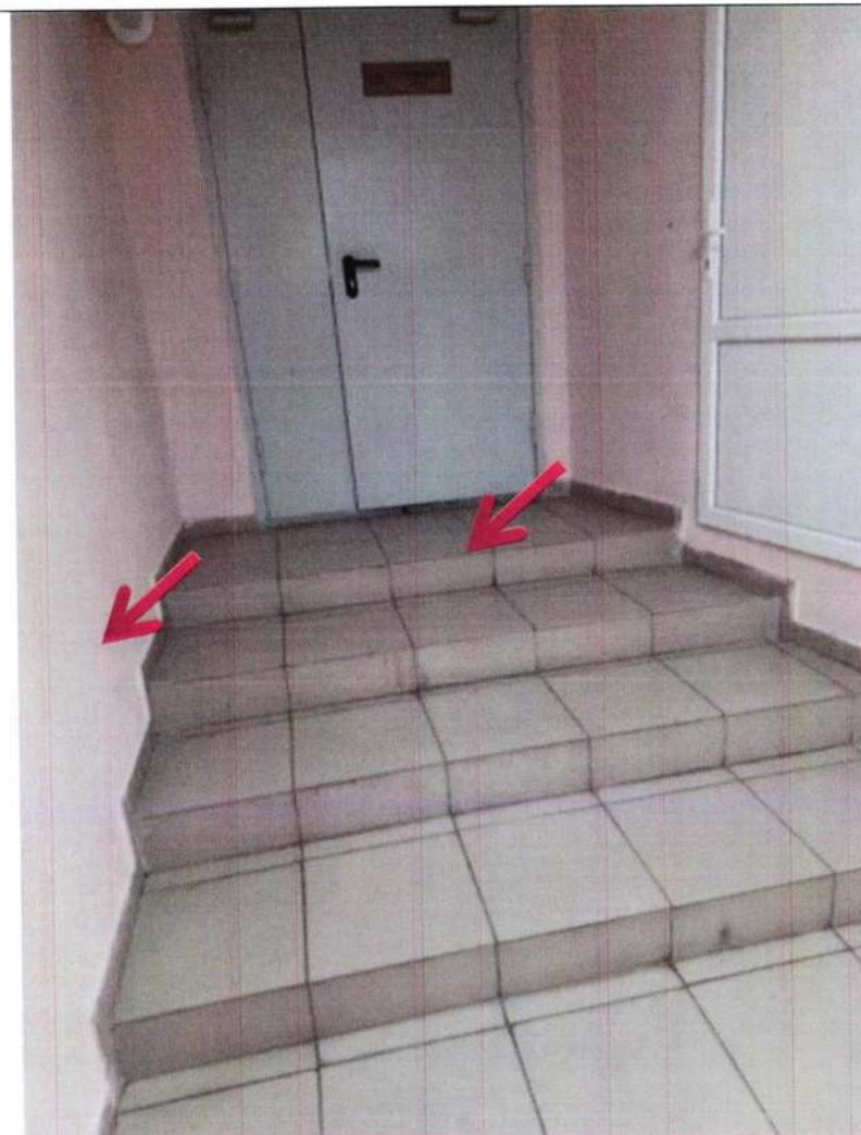
Фото № 12. Лестница по пути движения к спортивному залу. Ступени контрастно не маркированы. Нет поручней
