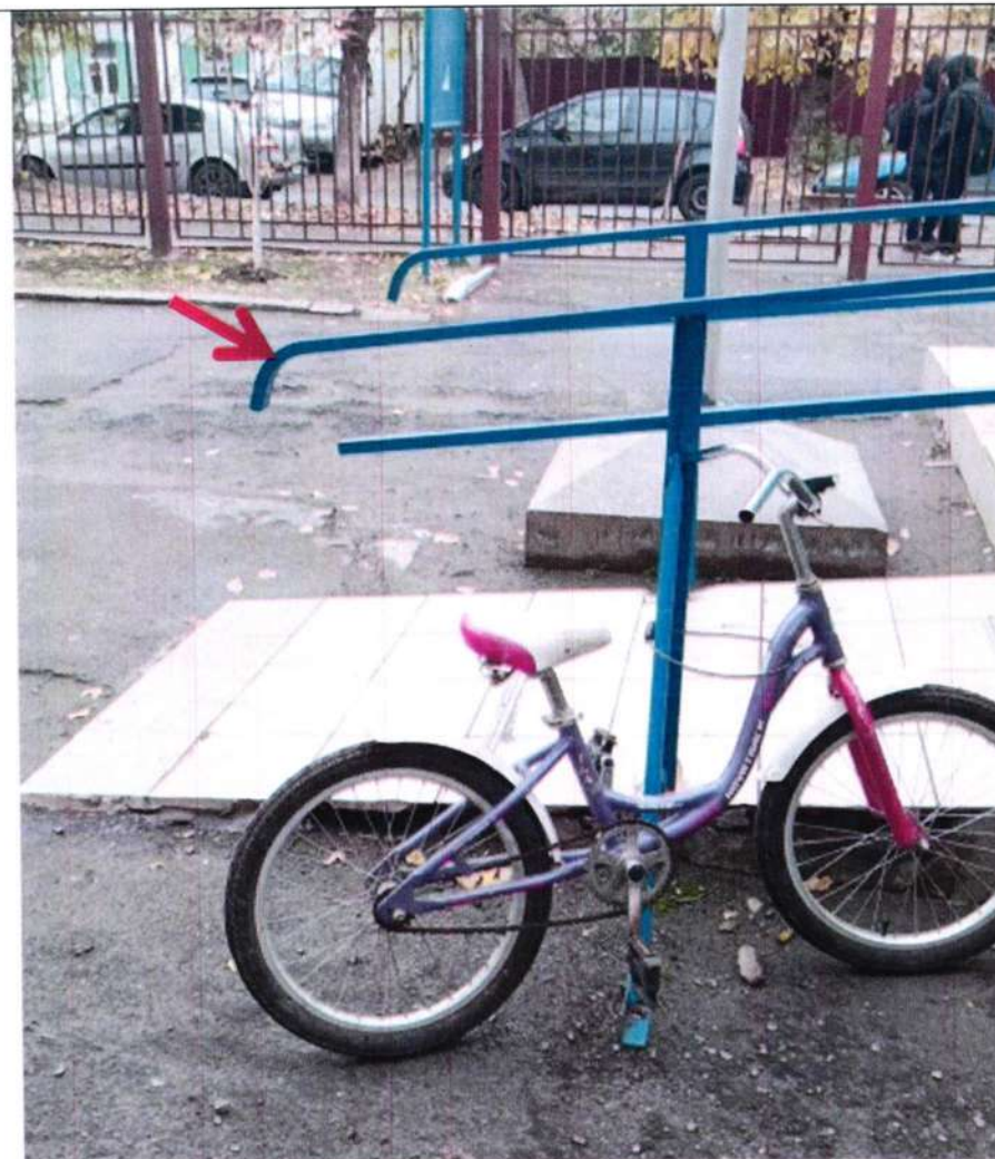
Фото № 6. Поручни с травмирующим завершением
