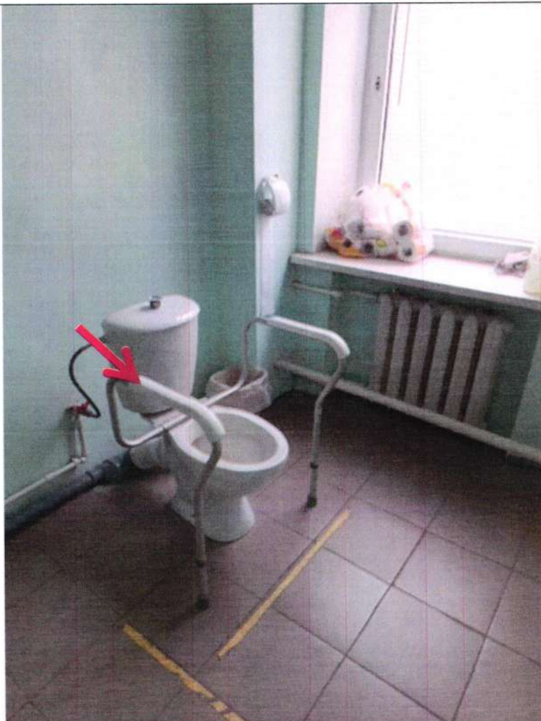
Фото № 31. Поручни не соответствуют требованиям нормативной документации
