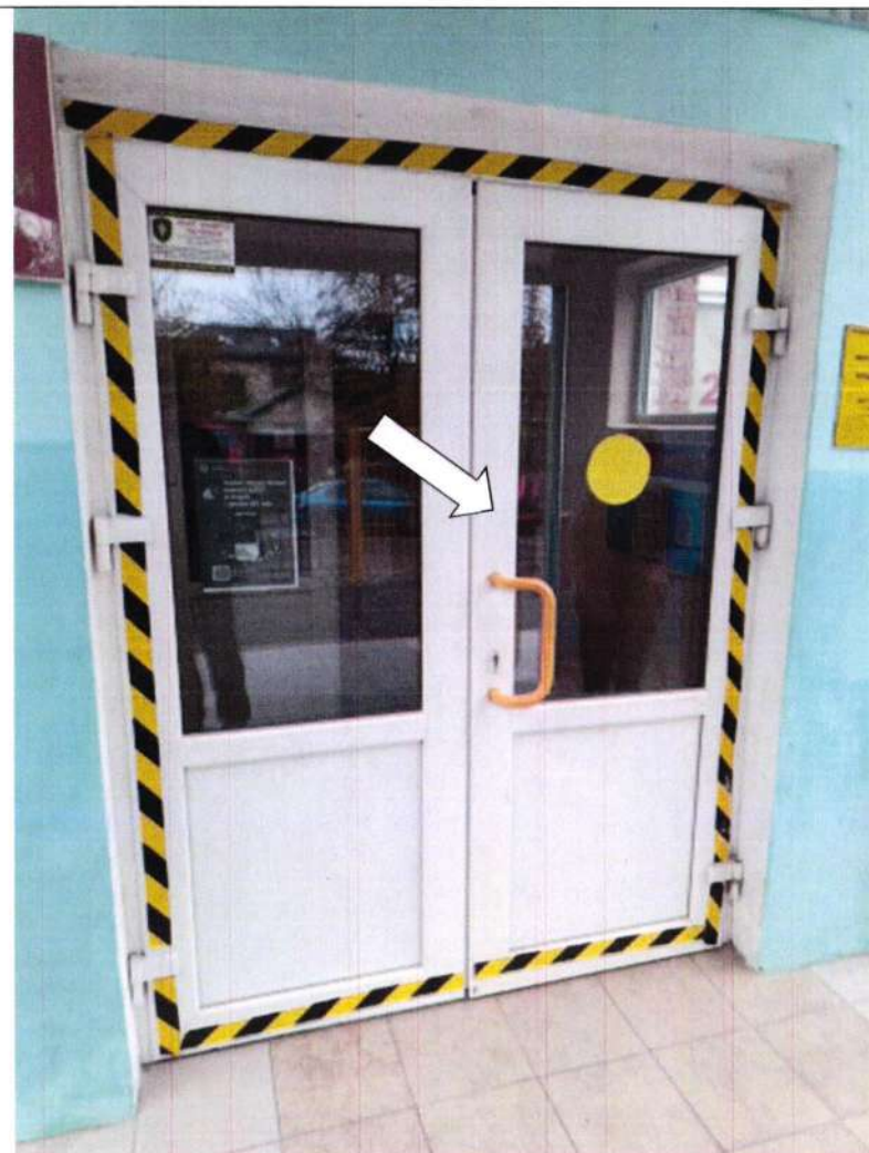
Фото № 8. Узкий дверной проем
