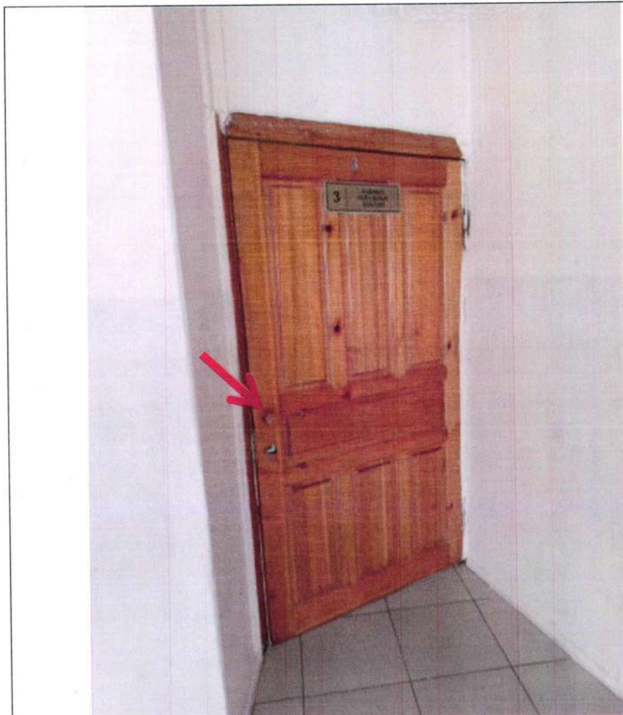
Фото № 21. Учебный кабинет. Дверная ручка круглая, неконтрастная. Нет тактильной таблички
