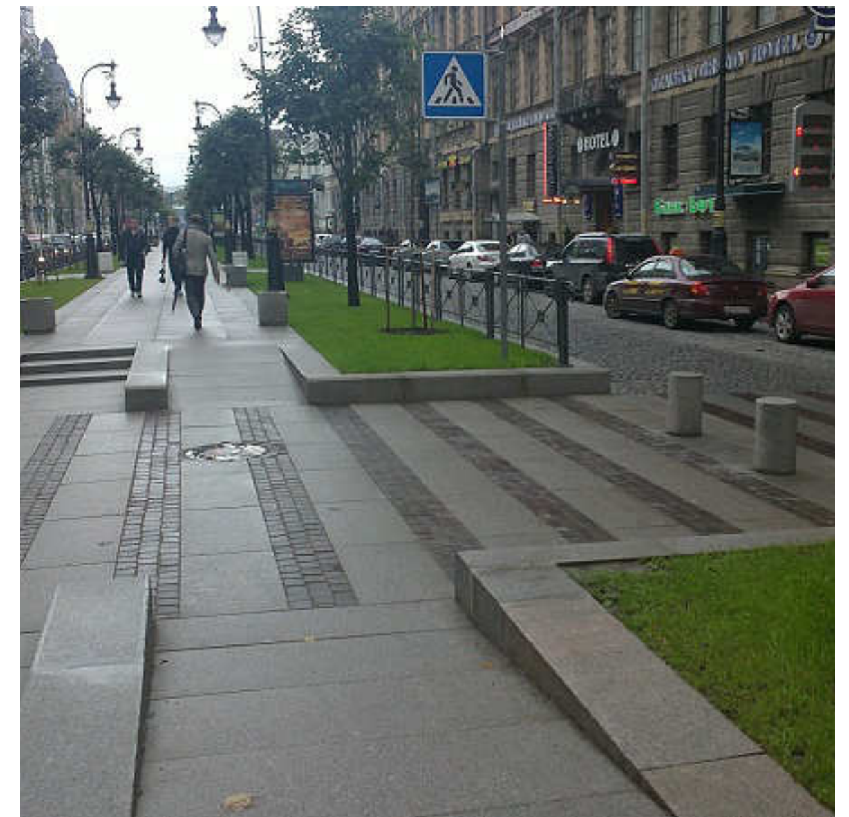
Реконструкция Большой Конюшенной улицы Санкт-Петербург, Россия 2010-2011
