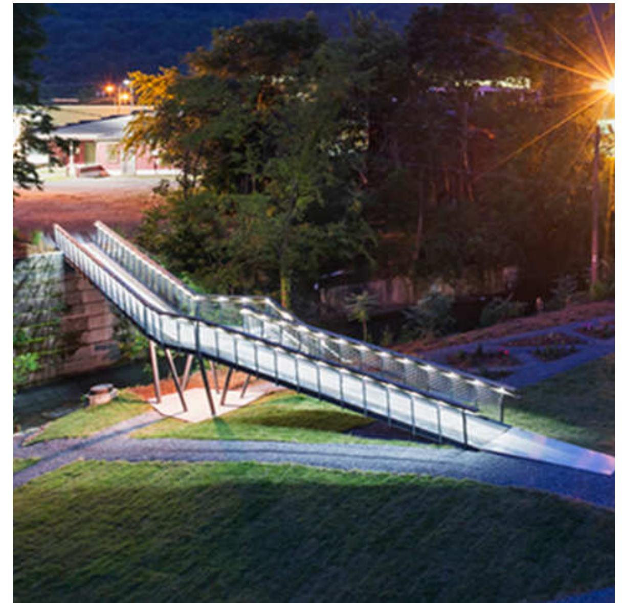
Пешеходный мост Smith Creek Авторы: buildLAB США 2013
