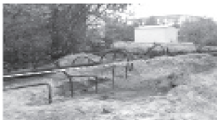
- Капитальный ремонт самотечного коллектора Ду 200 мм, L=144 м с узловым колодцем Ду 1420 мм, Н=2,2-5,2 м сети канализации КНС-82 в районе дома № 59 мкр. № 3.
