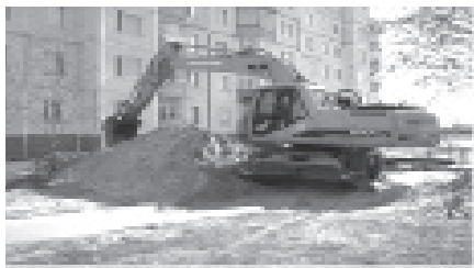
- Капитальный ремонт сетей ТВС здания ДК «Нефтяник»;
