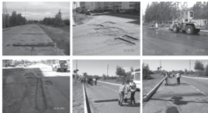
– ямочный ремонт асфальтобетонного покрытия на внутриквартальных дорогах
