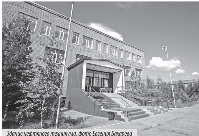
Здание нефтяного техникума, фото Евгения Бахарева
