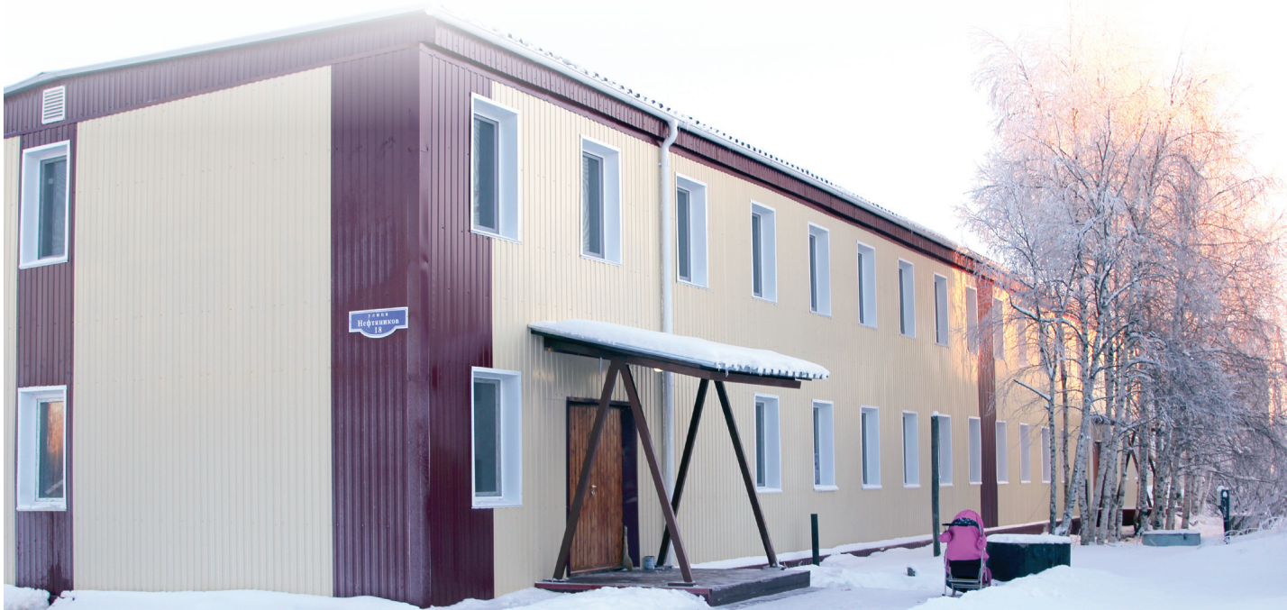
Введённое в эксплуатацию после комплексного ремонта общежитие №18 по ул. Нефтяников
