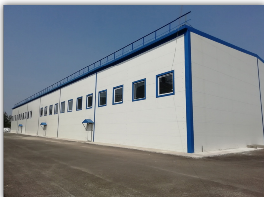
Рисунок №8 – Станция обезжелезивания №1 г.п. Лянтор
