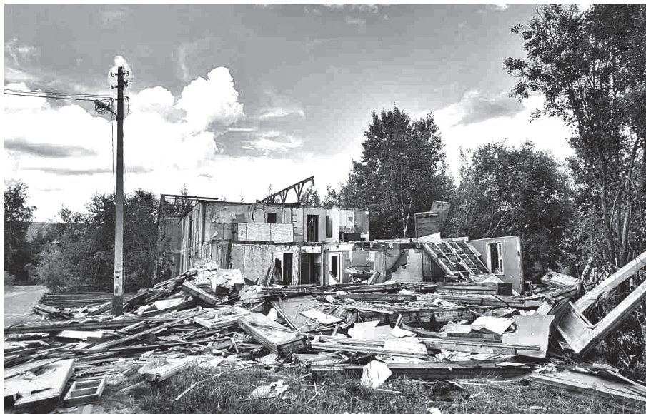
Снос жилого дома №55, 3 микрорайон, фото Евгения Бахарева
