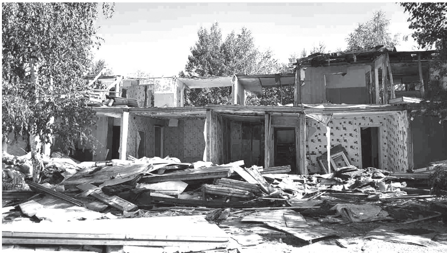
Снос жилого дома №1, 1 микрорайон, фото Евгения Бахарева
