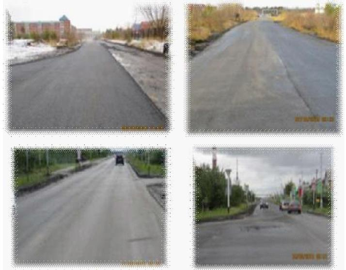
Срезанной асфальтобетонной крошкой от проведения ремонтных работ, силами ООО «ДСТ №1», была проведена отсыпка и планировка участков внутриквартальных дорог в микрорайонах №2, №3, №7, №10.
