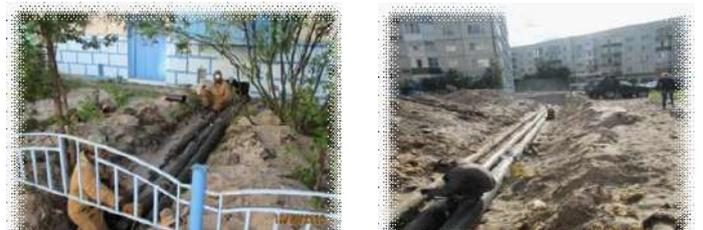
Общая протяженность замены ветхих сетей теплоснабжения и горячего водоснабжения в 2016 году составила – 3,9 км (в 2-х трубном исполнении), что составляет 3,44% от общей протяженности сетей, требующих замены, при рекомендованном минимальном нормативе 5%.
