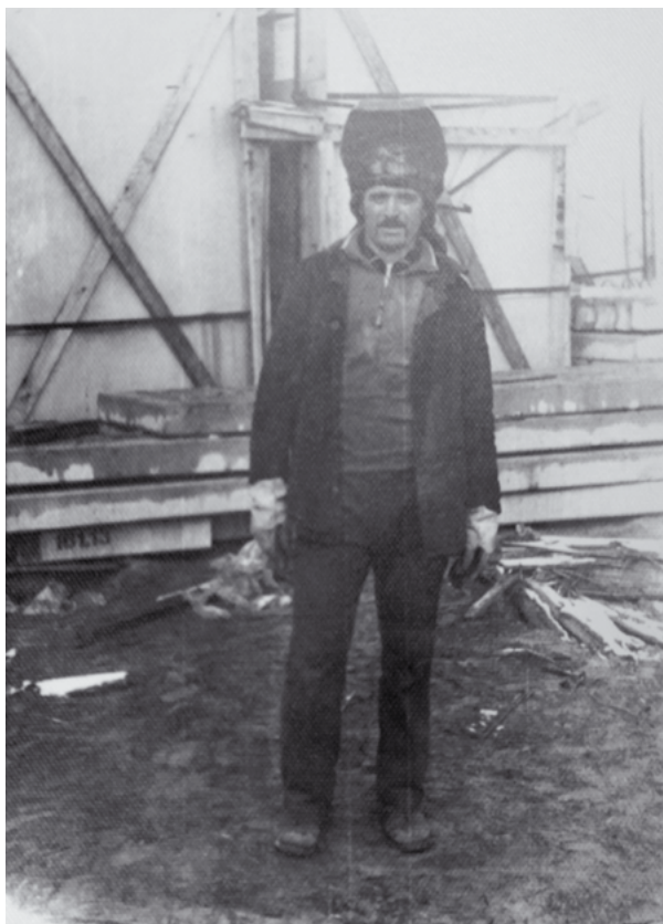
Строительство базы ПО «Сургутнефтегаз», 1985 год
