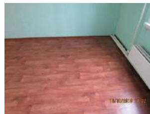
Ремонт жилого помещения (микрорайон 7, дом 34, кв.0)
