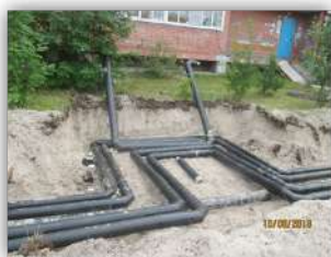
- капитальный ремонт сетей ТВС по адресу: от т/к магазин «Находка» до ж/д №2, микрорайон №6:
