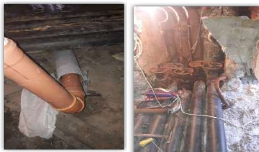
Улица Эстонских дорожников, дома №№ 29,29А,31,33 - капитальный ремонт сетей водоотведения
