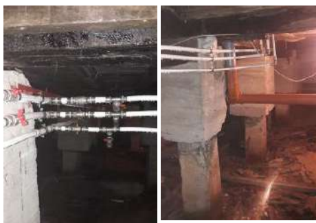
микрорайон №3, дом №46 - капитальный ремонт горячего водоснабжения, холодного водоснабжения, водоотведения, теплоснабжения.
