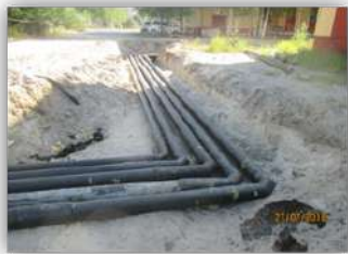
- капитальный ремонт сетей ТВС. Адрес: микрорайон №6 от ЦТП №56 до ТК №6-56-1П:
