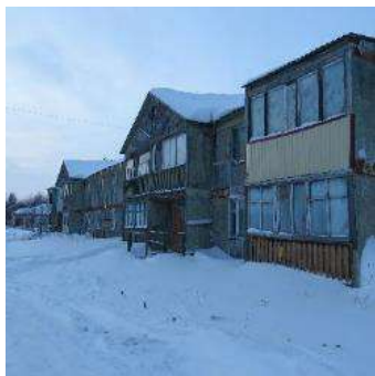
Дом № 26 в 7-м микрорайоне
