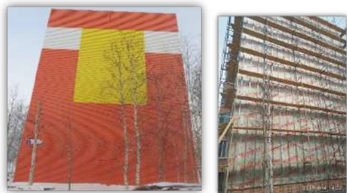
Микрорайон №4, дом №2 – ремонт фасада
