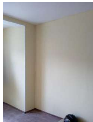
Ремонт жилого помещения (микрорайон 4, дом 15, кв. 119)
