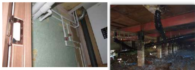
улица Эстонских Дорожников, дом №25 - капитальный ремонт горячего водоснабжения, холодного водоснабжения, водоотведения, теплоснабжения
