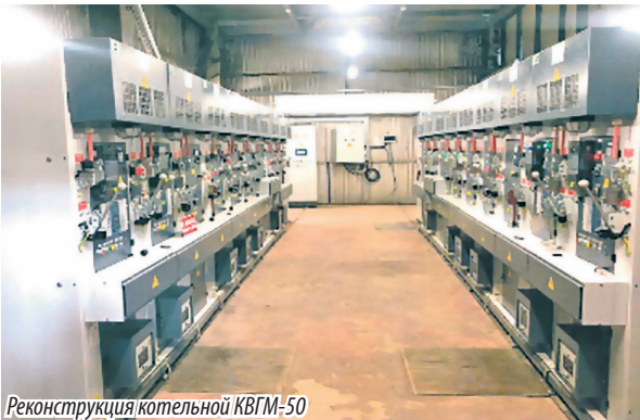
Реконструкция котельной КВГМ-50
