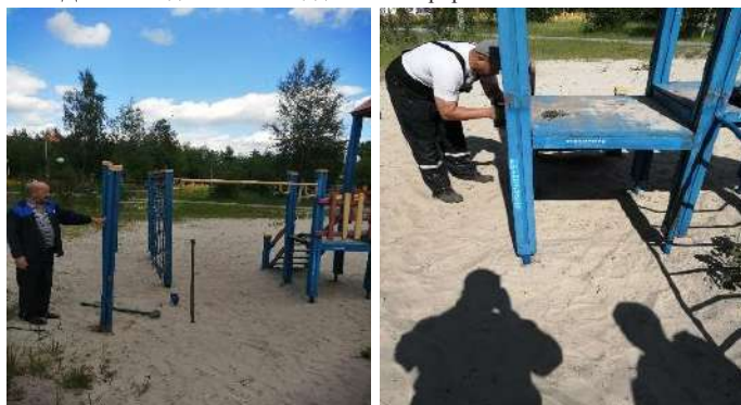
Демонтаж детской площадки по улице Сергея Лазо
