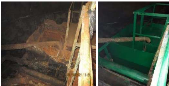
5. Выполнены работы по капитальному ремонту изоляции надземных сетей ТС и ХВС на территории ВОС – 597,00 тыс. руб.
