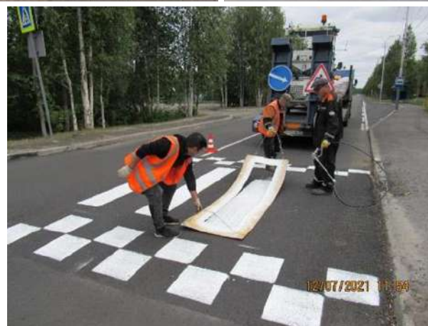
Разметка дорожного покрытия пластиком
