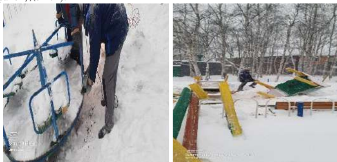
Демонтаж детской площадки в 1 микрорайоне:
