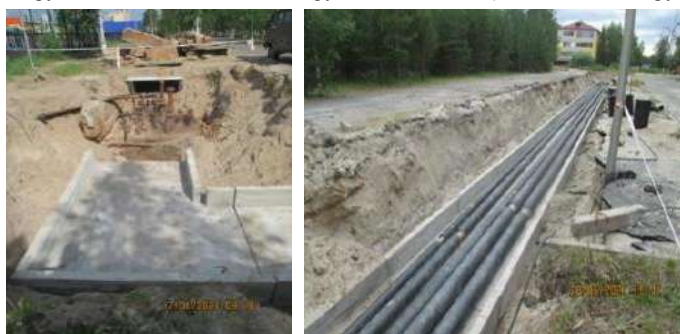
2. Капитальный ремонт котла №3 котельной №2 – 6 886,38 тыс. руб.
