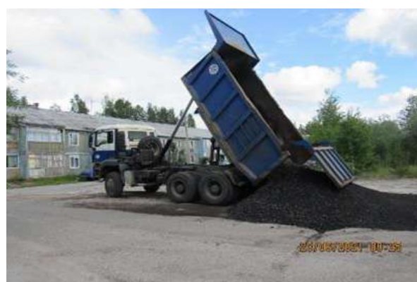
Отсыпка обочины внутриквартального проезда в 3 микрорайоне
