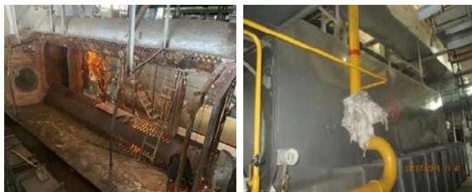
3. Капитальный ремонт ЦТП №5 с заменой кожухотрубных теплообменников на пластинчатые, с последующей переобвязкой трубопроводов – 1 014,39 тыс. руб.
