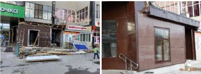
«до реконструкции» «после реконструкции»
