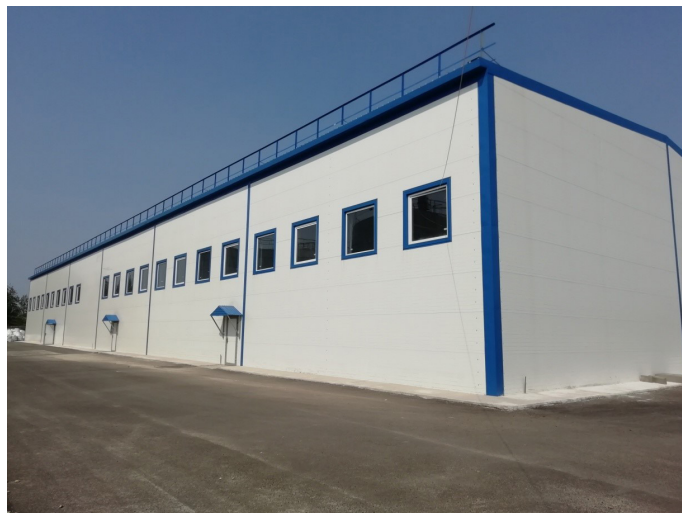
Рисунок №8 – Станция обезжелезивания №1 г.п. Лянтор
