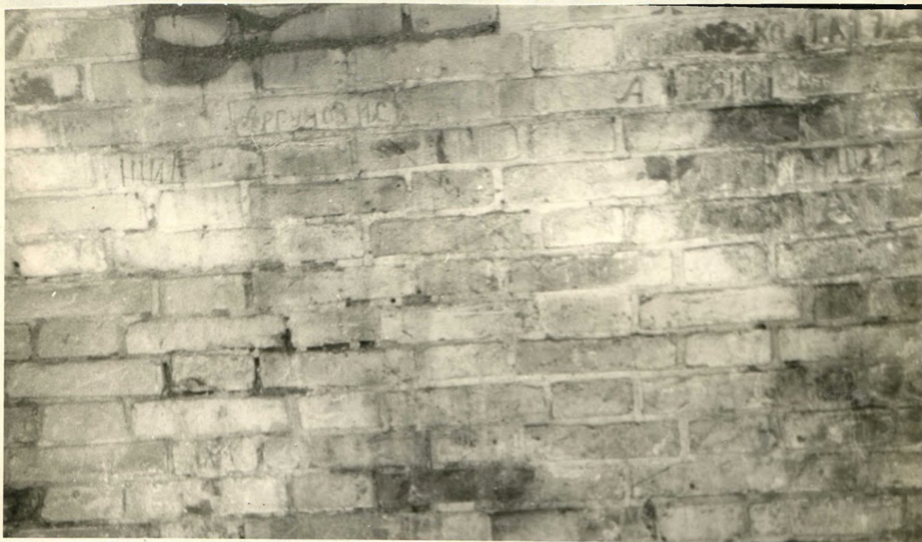
Стена подвала, где истязали советских людей. Фото 1971 года.
