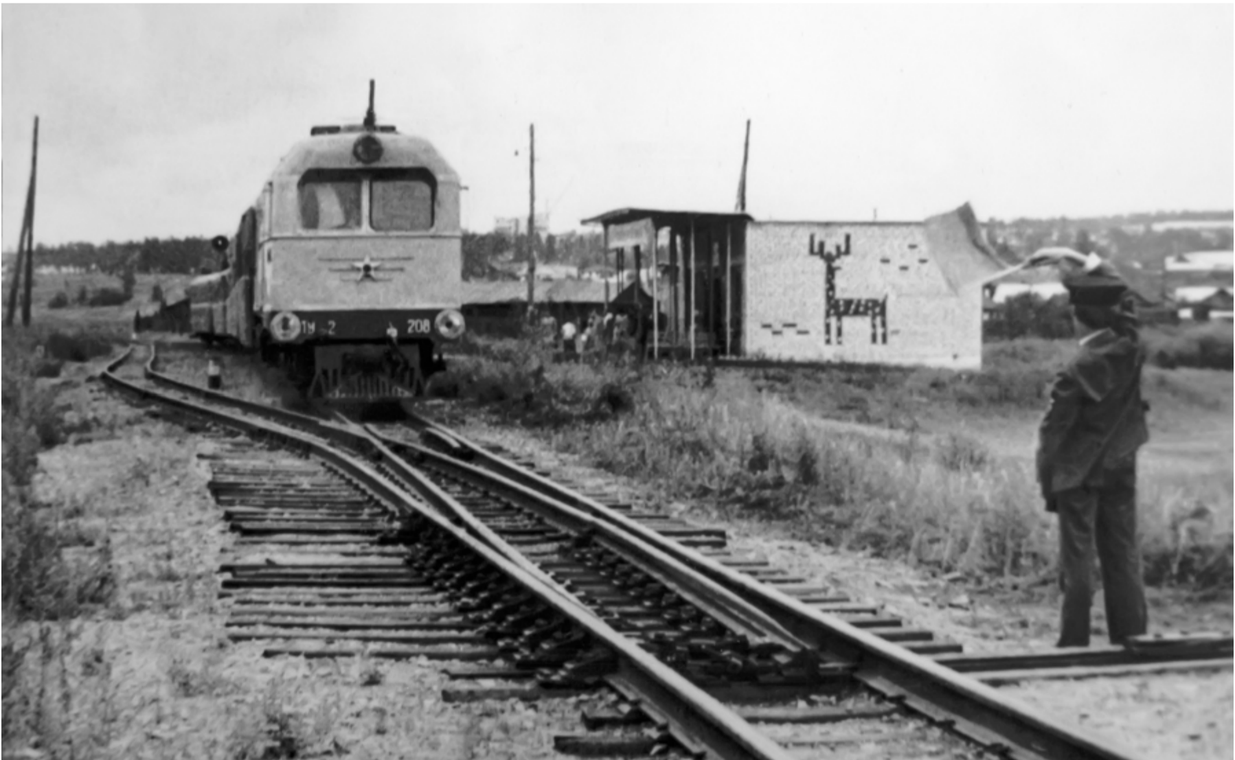
Станция Пионерская без светофоров
