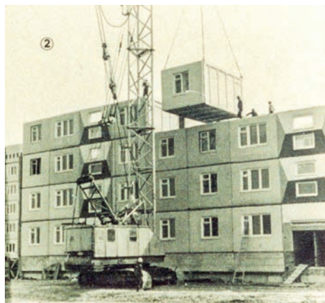
Монтаж объемных блоков. 1976
