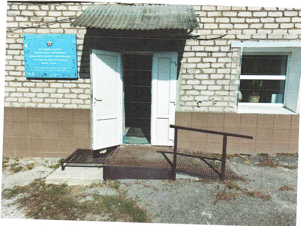
№ 3. Входная площадка перед дверью. Дверь входная
