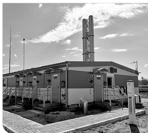
Газораспределительная станция понижает давление газа из магистрального трубопровода до уровня, необходимого для безопасного потребления.
