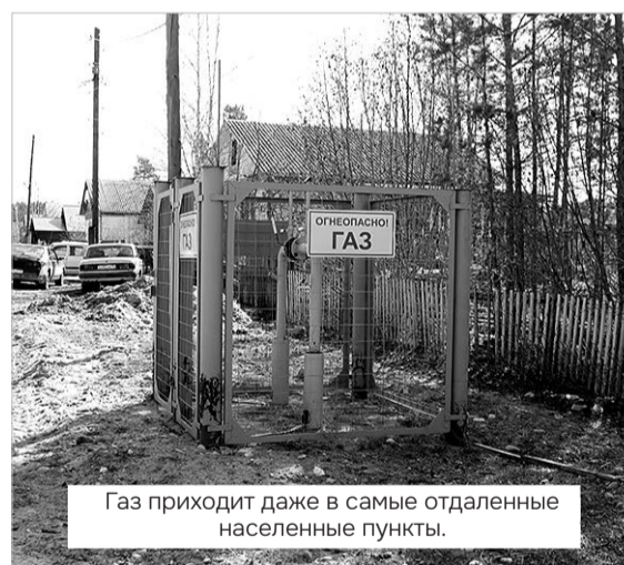
Газораспределительная станция понижает давление газа из магистрального трубопровода до уровня, необходимого для безопасного потребления.
