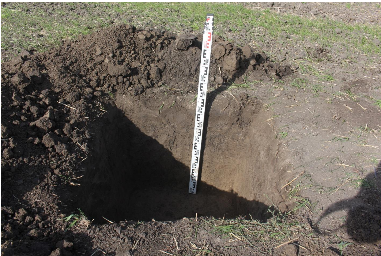
Рис. 144. Херсонская область. Строительство ВЛ 330 кВ Геническая - Мелитопольская. Территория исследований. Шурф 28. Профиль северного борта. Вид с юга.
