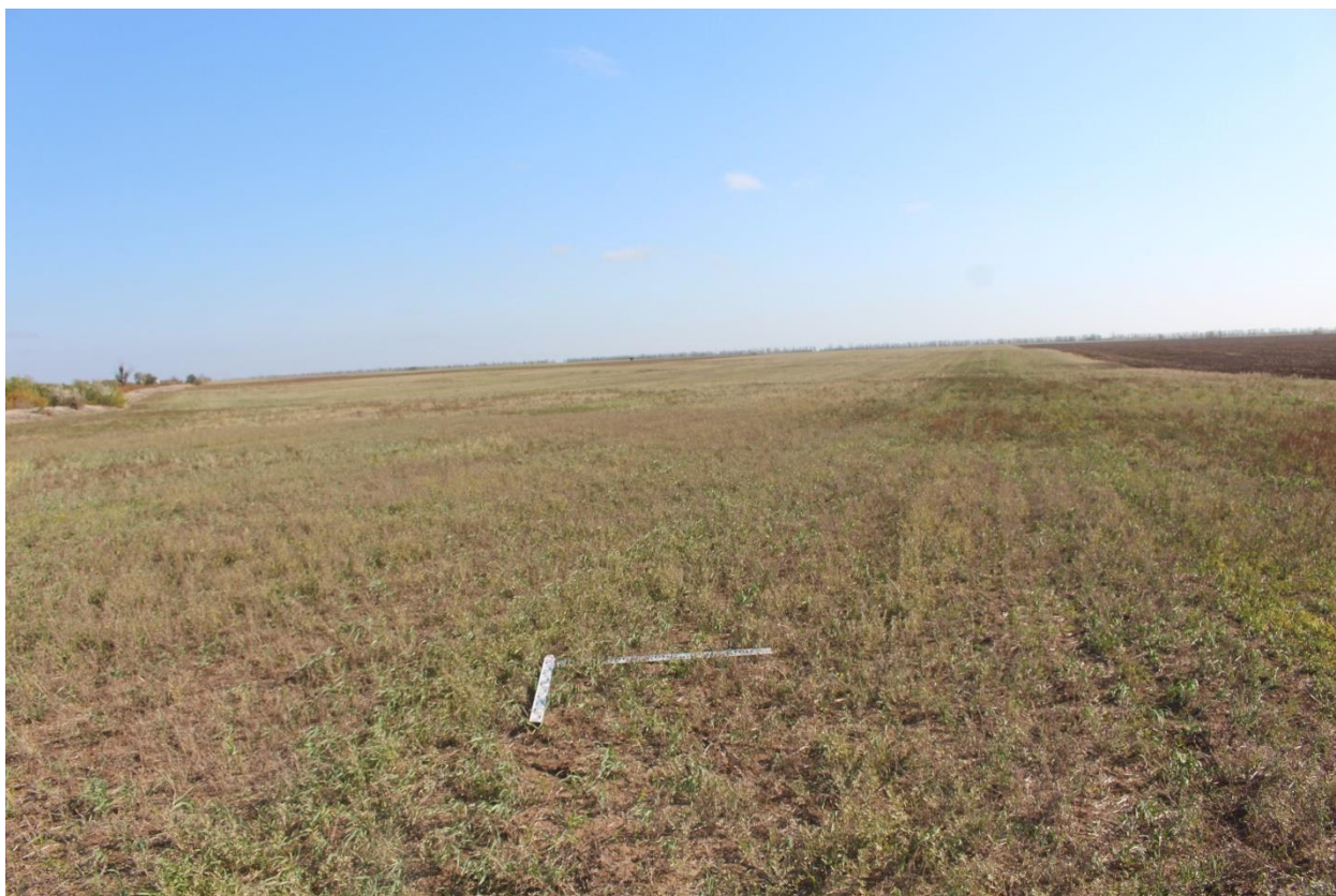
Рис. 114. Херсонская область. Строительство ВЛ 330 кВ Геническая - Мелитопольская. Территория исследований. Шурф 13 до начала работ. Вид с юга.
