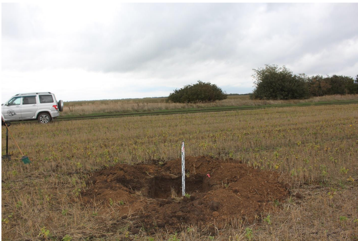
Рис. 99. Херсонская область. Строительство ВЛ 330 кВ Геническая - Мелитопольская. Территория исследований. Шурф 9 после окончания работ. Вид с юга.
