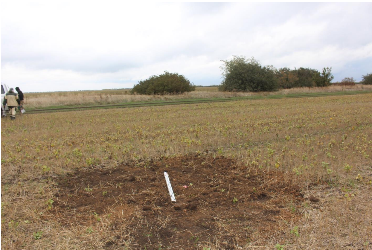
Рис. 101. Херсонская область. Строительство ВЛ 330 кВ Геническая - Мелитопольская. Территория исследований. Шурф 9 после консервации. Вид с юга.
