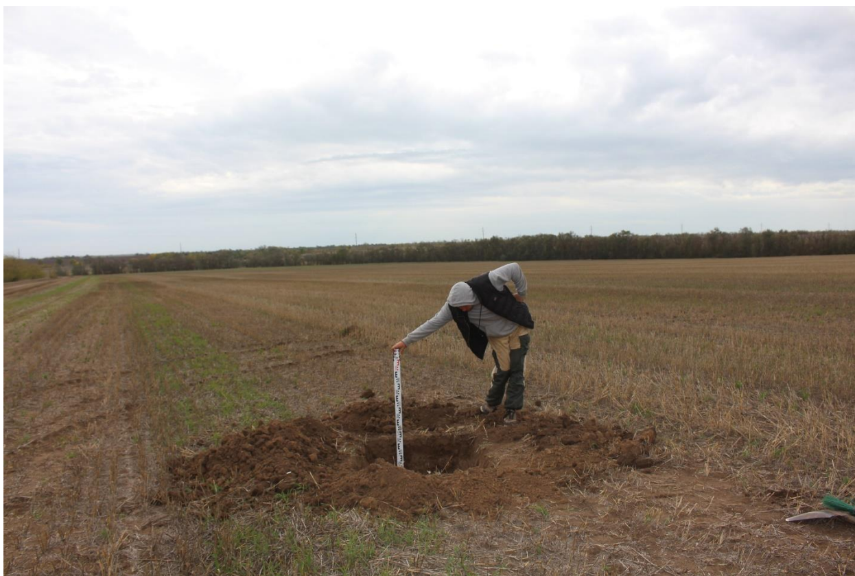
Рис. 131. Херсонская область. Строительство ВЛ 330 кВ Геническая - Мелитопольская. Территория исследований. Шурф 17 после окончания работ. Вид с юга.
