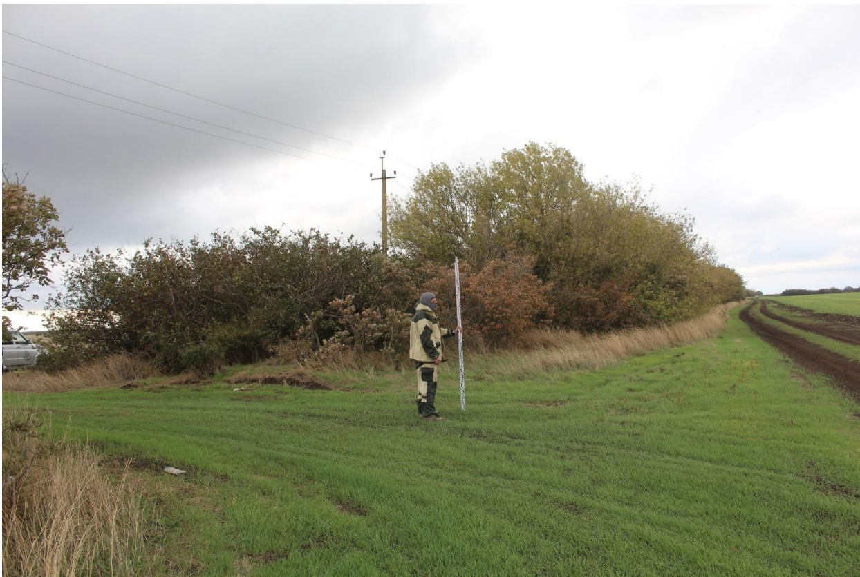
Рис. 14. Херсонская область. Строительство ВЛ 330 кВ Геническая - Мелитопольская. Территория исследований. Точка фотофиксации 6. Вид с востока.
