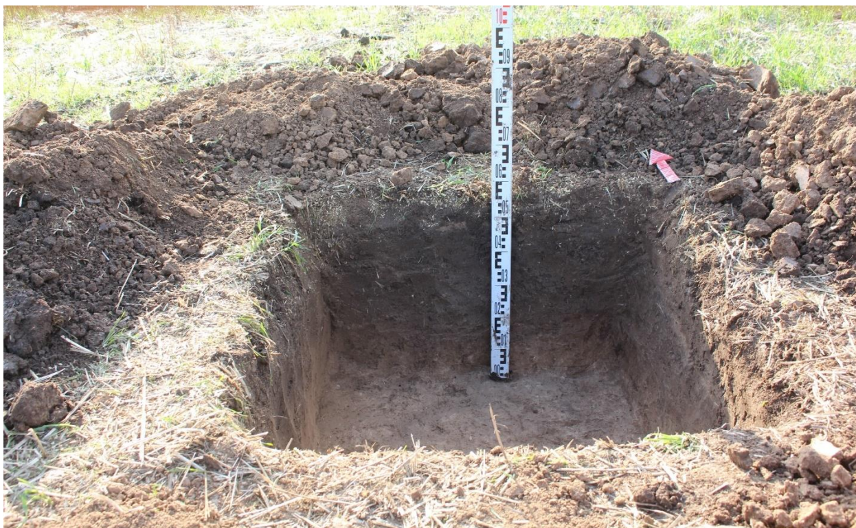
Рис. 148. Херсонская область. Строительство ВЛ 330 кВ Геническая - Мелитопольская. Территория исследований. Шурф 29. Профиль северного борта. Вид с юга.
