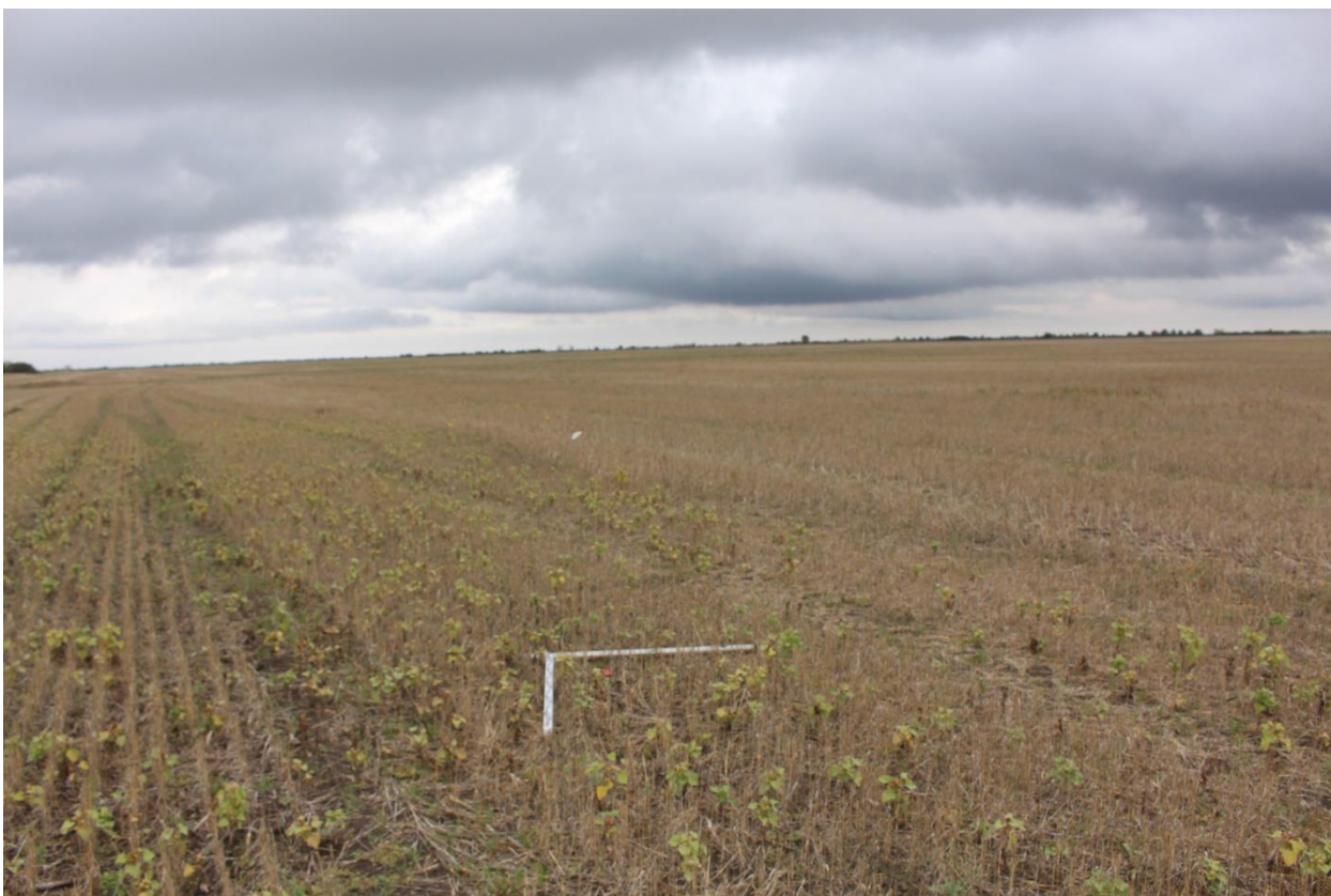
Рис. 70. Херсонская область. Строительство ВЛ 330 кВ Геническая - Мелитопольская. Территория исследований. Шурф 2 до начала работ. Вид с юга.
