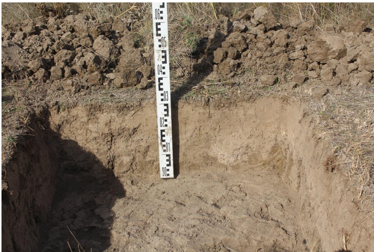
Рис. 136. Херсонская область. Строительство ВЛ 330 кВ Геническая - Мелитопольская. Территория исследований. Шурф 18. Профиль северного борта. Вид с юга.
