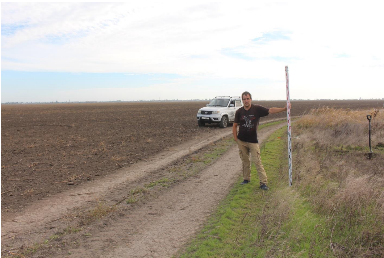
Рис. 16. Херсонская область. Строительство ВЛ 330 кВ Геническая - Мелитопольская. Территория исследований. Точка фотофиксации 8. Вид с севера.
