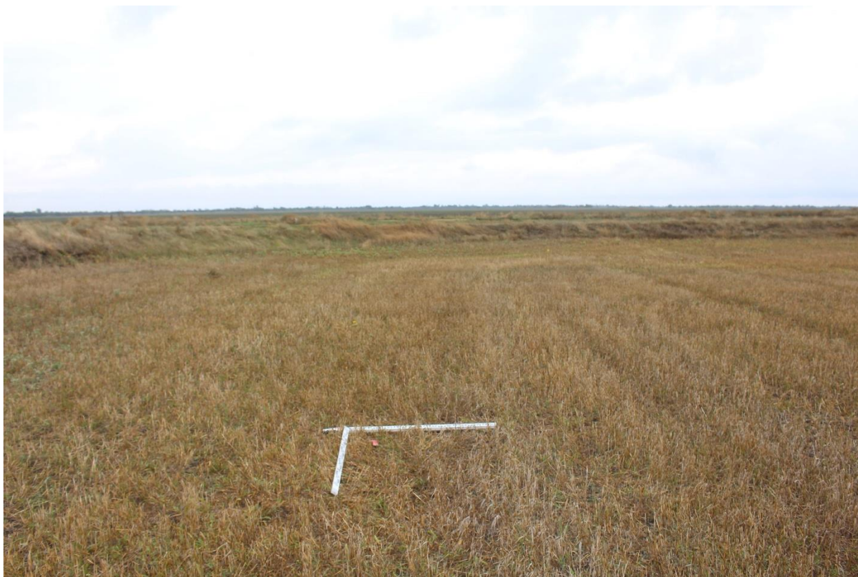
Рис. 66. Херсонская область. Строительство ВЛ 330 кВ Геническая - Мелитопольская. Территория исследований. Шурф 1 до начала работ. Вид с юга.
