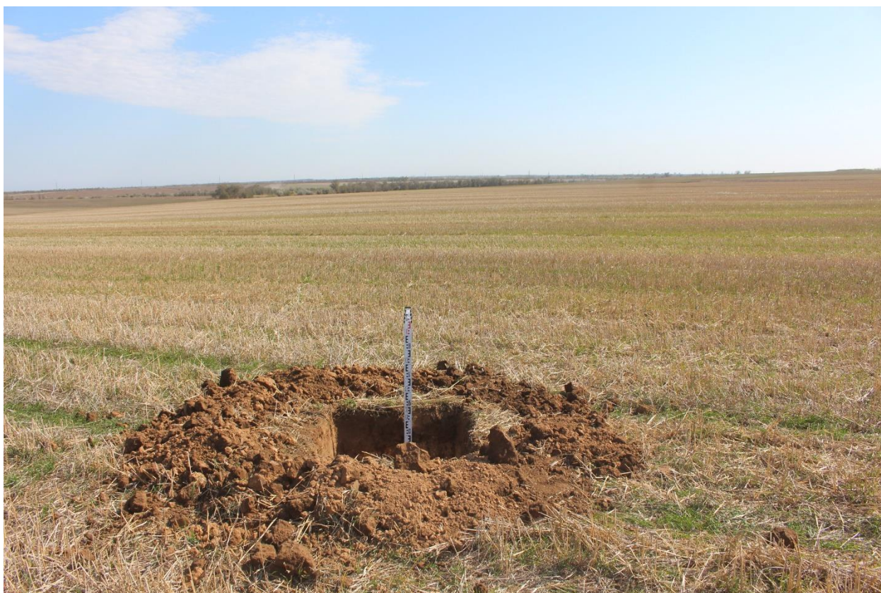
Рис. 107. Херсонская область. Строительство ВЛ 330 кВ Геническая - Мелитопольская. Территория исследований. Шурф 11 после окончания работ. Вид с юга.
