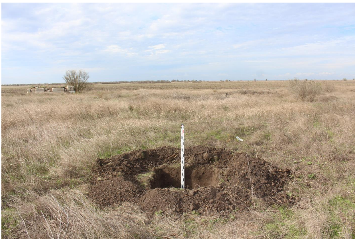
Рис. 151. Херсонская область. Строительство ВЛ 330 кВ Геническая - Мелитопольская. Территория исследований. Шурф 30 после окончания работ. Вид с юга.
