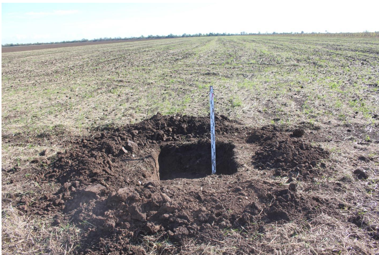
Рис. 155. Херсонская область. Строительство ВЛ 330 кВ Геническая - Мелитопольская. Территория исследований. Шурф 31 после окончания работ. Вид с юга.
