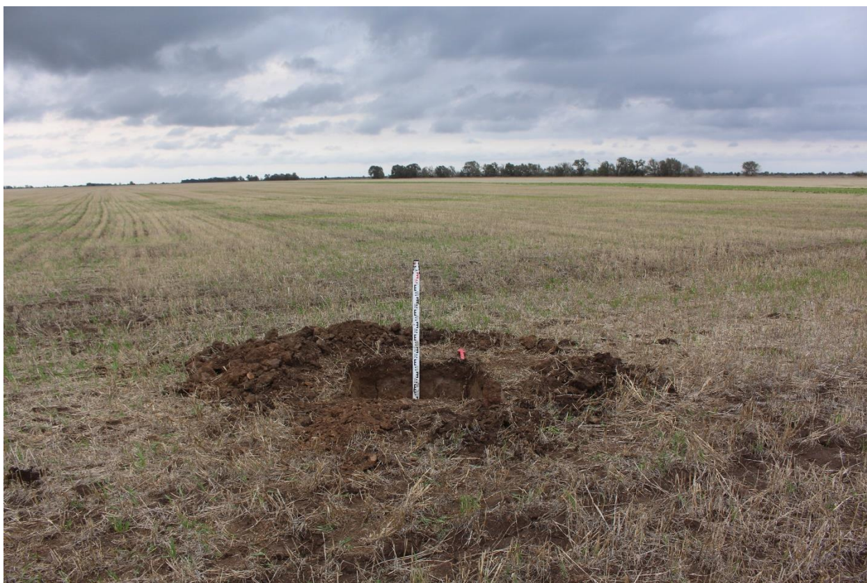
Рис. 83. Херсонская область. Строительство ВЛ 330 кВ Геническая - Мелитопольская. Территория исследований. Шурф 5 после окончания работ. Вид с юга.
