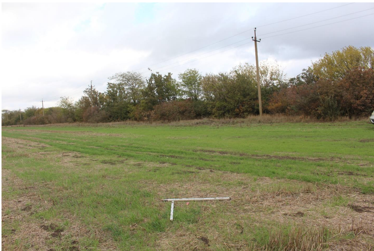
Рис. 86. Херсонская область. Строительство ВЛ 330 кВ Геническая - Мелитопольская. Территория исследований. Шурф 6 до начала работ. Вид с юга.
