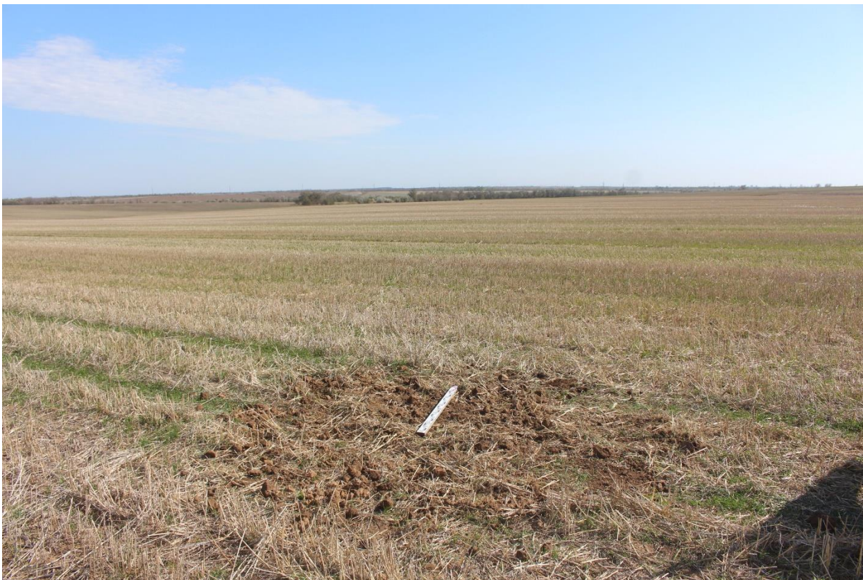
Рис. 109. Херсонская область. Строительство ВЛ 330 кВ Геническая - Мелитопольская. Территория исследований. Шурф 11 после консервации. Вид с юга.
