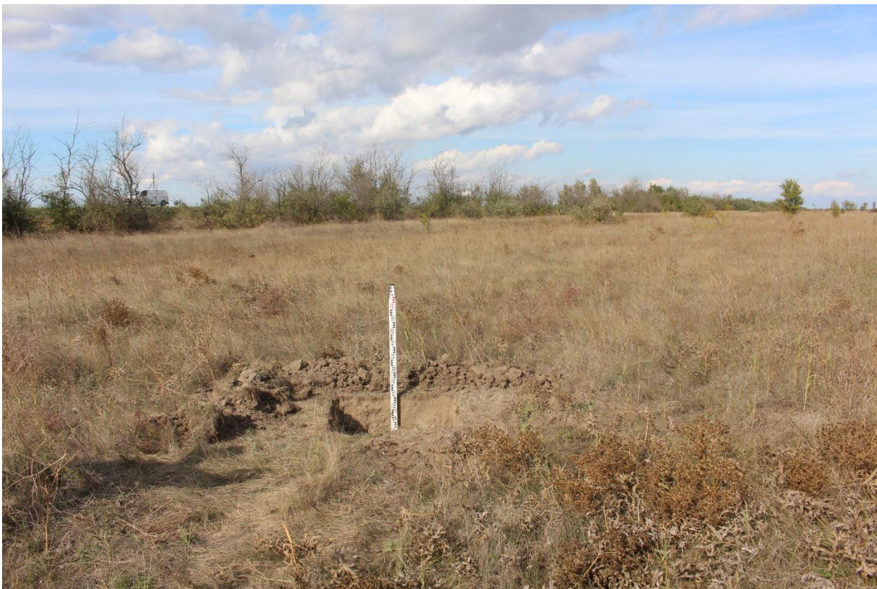
Рис. 135. Херсонская область. Строительство ВЛ 330 кВ Геническая - Мелитопольская. Территория исследований. Шурф 18 после окончания работ. Вид с юга.
