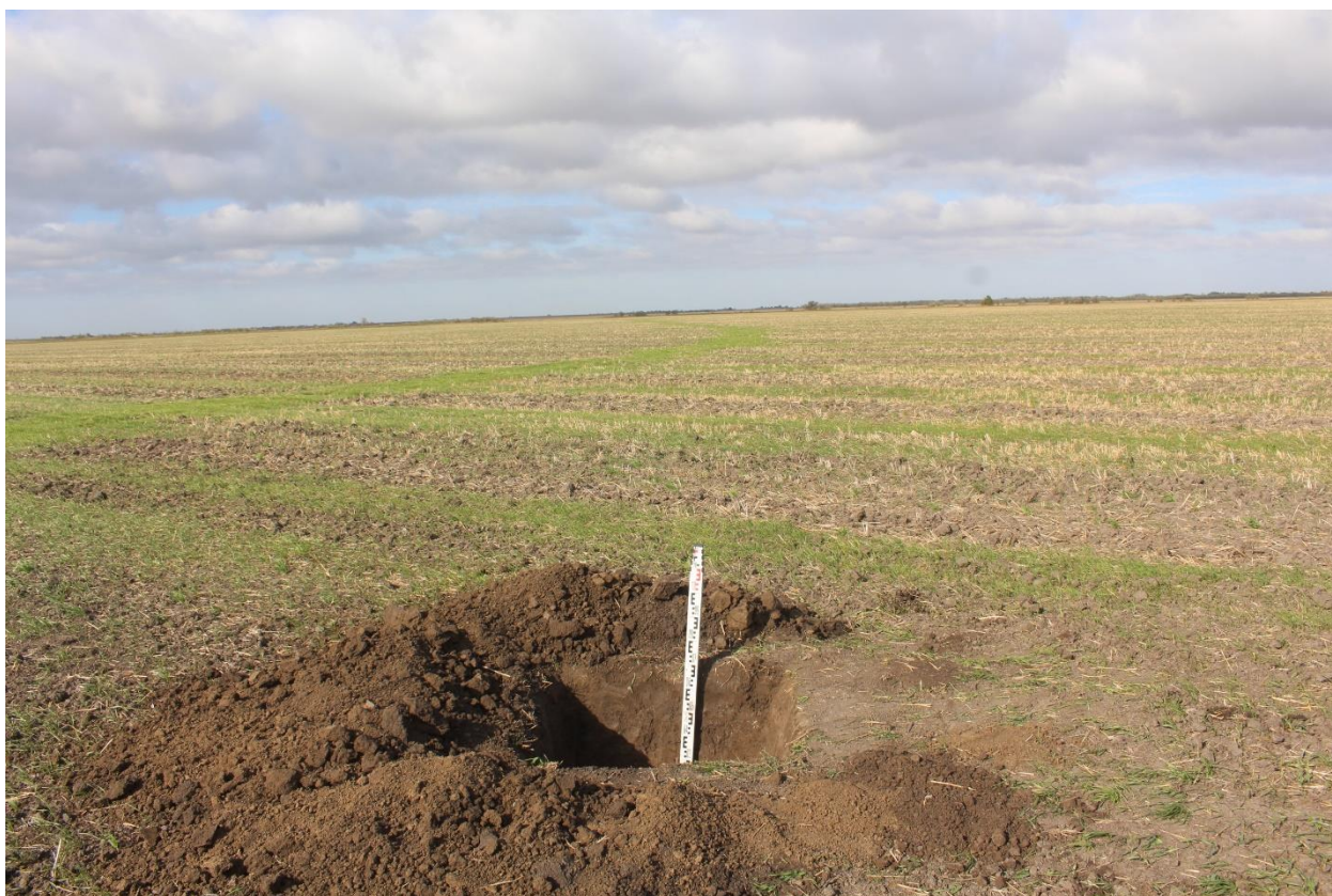
Рис. 143. Херсонская область. Строительство ВЛ 330 кВ Геническая - Мелитопольская. Территория исследований. Шурф 28 после окончания работ. Вид с юга.
