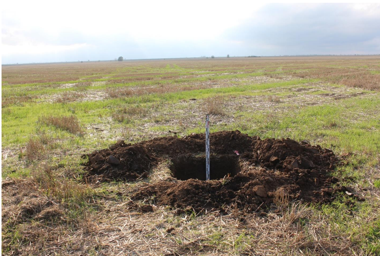
Рис. 147. Херсонская область. Строительство ВЛ 330 кВ Геническая - Мелитопольская. Территория исследований. Шурф 29 после окончания работ. Вид с юга.
