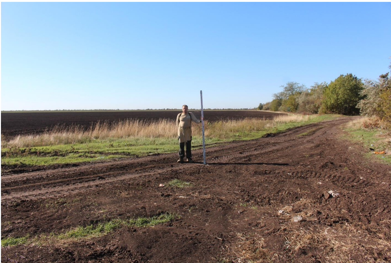
Рис. 20. Херсонская область. Строительство ВЛ 330 кВ Геническая - Мелитопольская. Территория исследований. Точка фотофиксации 12. Вид с севера.
