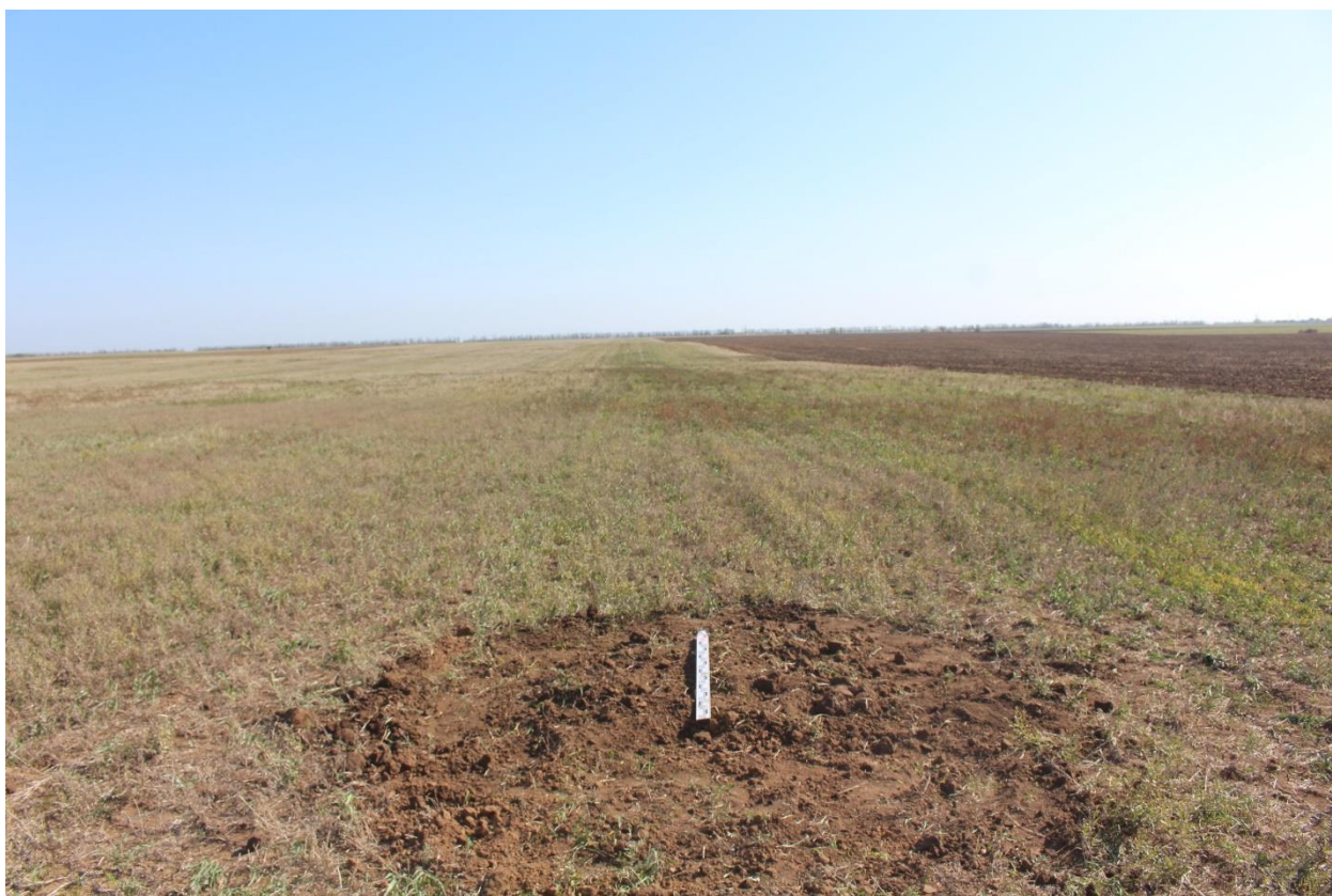
Рис. 117. Херсонская область. Строительство ВЛ 330 кВ Геническая - Мелитопольская. Территория исследований. Шурф 13 после консервации. Вид с юга.
