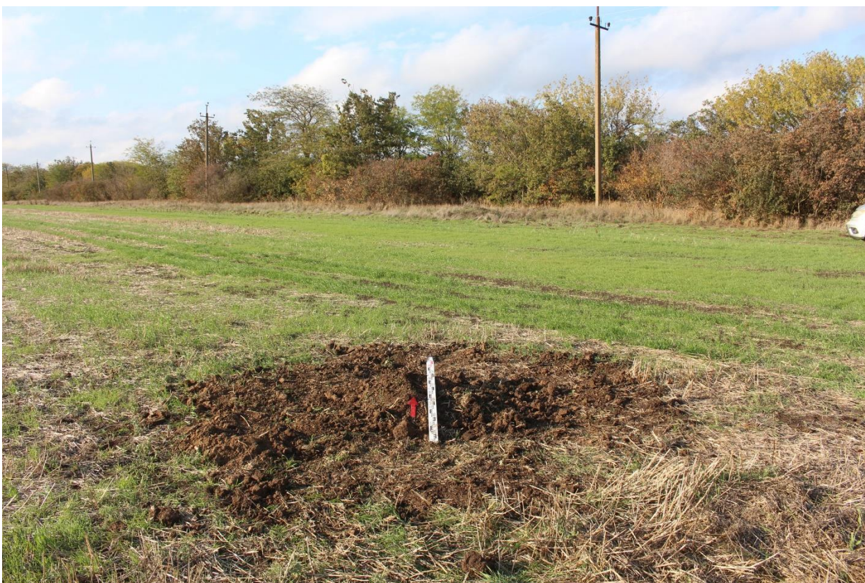
Рис. 89. Херсонская область. Строительство ВЛ 330 кВ Геническая - Мелитопольская. Территория исследований. Шурф 6 после консервации. Вид с юга.
