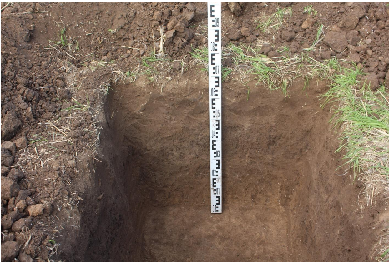
Рис. 160. Херсонская область. Строительство ВЛ 330 кВ Геническая - Мелитопольская. Территория исследований. Шурф 32. Профиль северного борта. Вид с юга.
