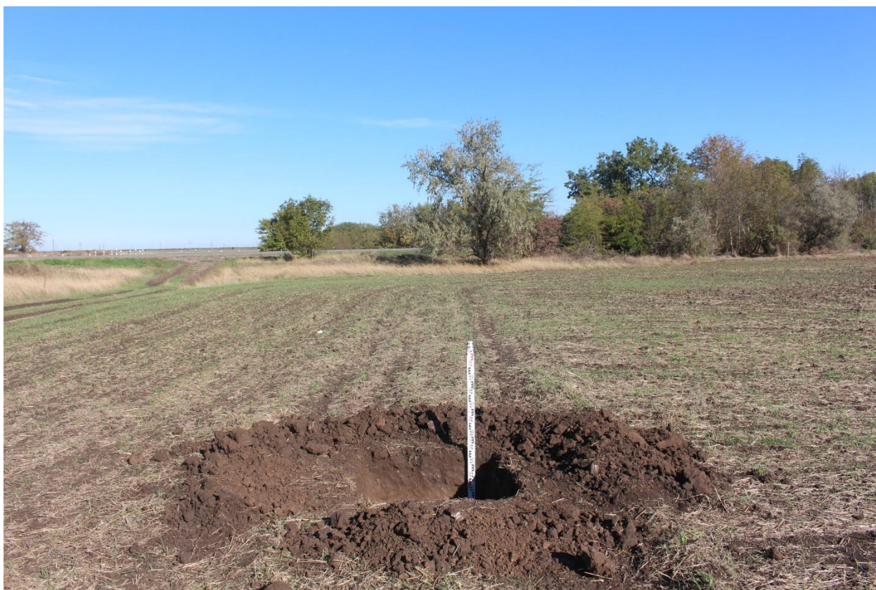
Рис. 95. Херсонская область. Строительство ВЛ 330 кВ Геническая - Мелитопольская. Территория исследований. Шурф 8 после окончания работ. Вид с юга.
