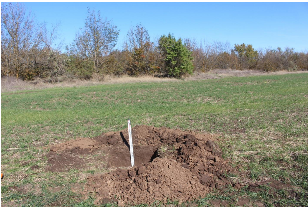
Рис. 103. Херсонская область. Строительство ВЛ 330 кВ Геническая - Мелитопольская. Территория исследований. Шурф 10 после окончания работ. Вид с юга.
