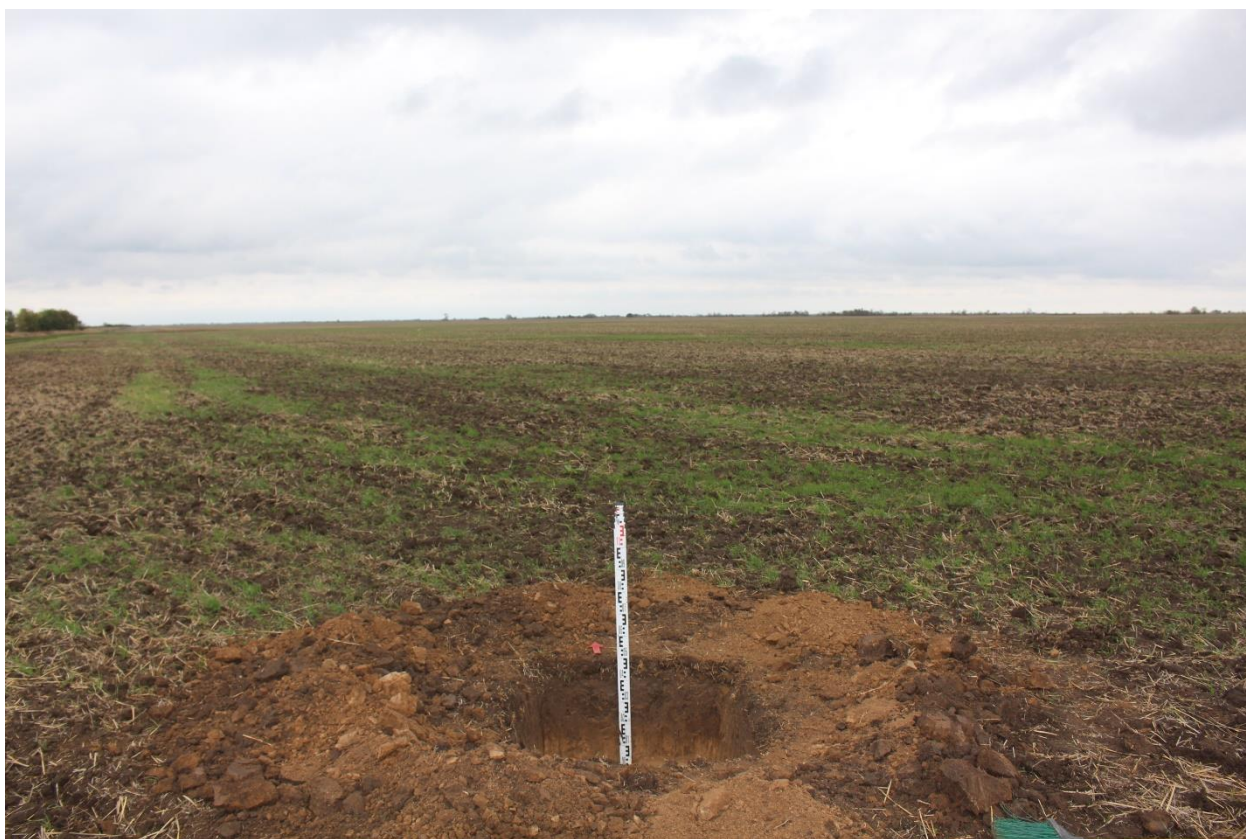
Рис. 75. Херсонская область. Строительство ВЛ 330 кВ Геническая - Мелитопольская. Территория исследований. Шурф 3 после окончания работ. Вид с юга.
