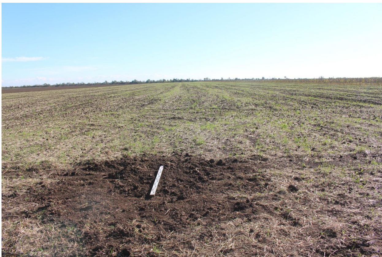
Рис. 157. Херсонская область. Строительство ВЛ 330 кВ Геническая - Мелитопольская. Территория исследований. Шурф 31 после консервации. Вид с юга.
