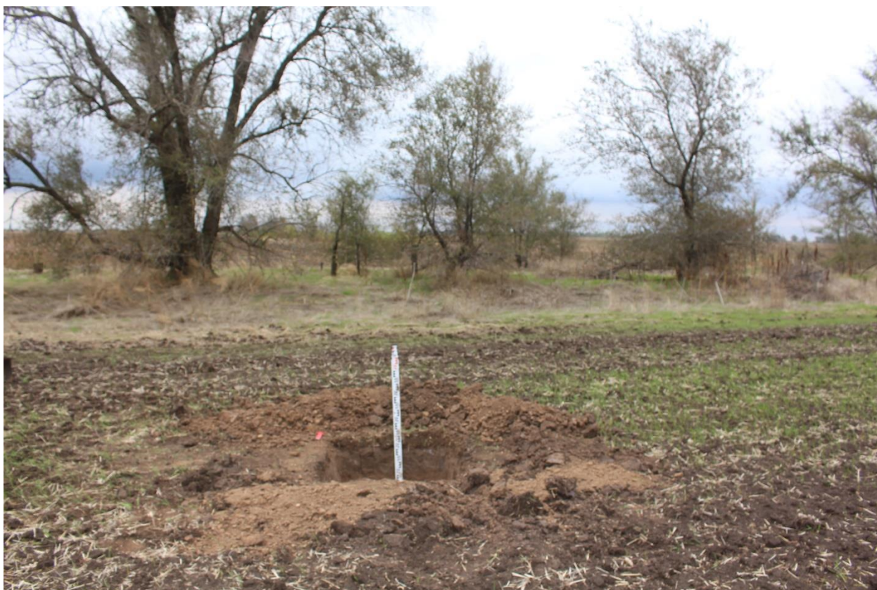
Рис. 79. Херсонская область. Строительство ВЛ 330 кВ Геническая - Мелитопольская. Территория исследований. Шурф 4 после окончания работ. Вид с юга.
