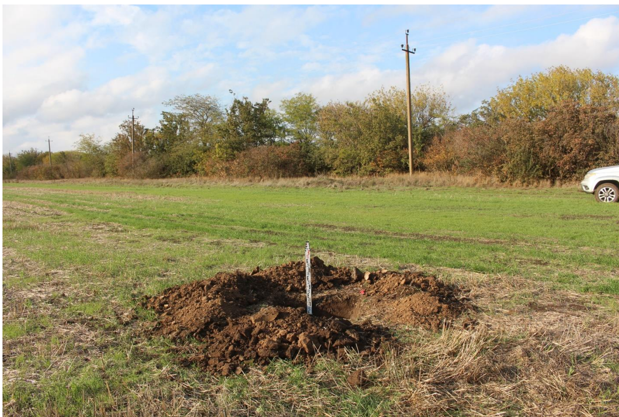
Рис. 87. Херсонская область. Строительство ВЛ 330 кВ Геническая - Мелитопольская. Территория исследований. Шурф 6 после окончания работ. Вид с юга.
