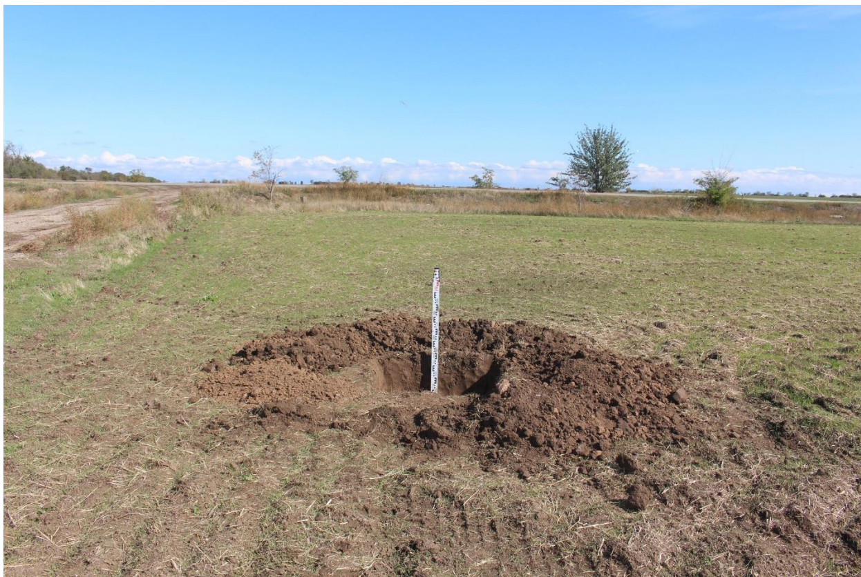
Рис. 111. Херсонская область. Строительство ВЛ 330 кВ Геническая - Мелитопольская. Территория исследований. Шурф 12 после окончания работ. Вид с юга.
