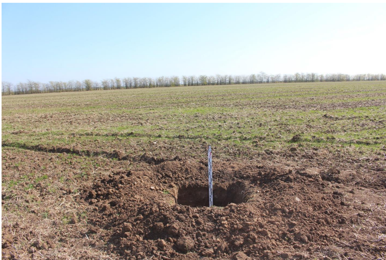
Рис. 123. Херсонская область. Строительство ВЛ 330 кВ Геническая - Мелитопольская. Территория исследований. Шурф 15 после окончания работ. Вид с юга.
