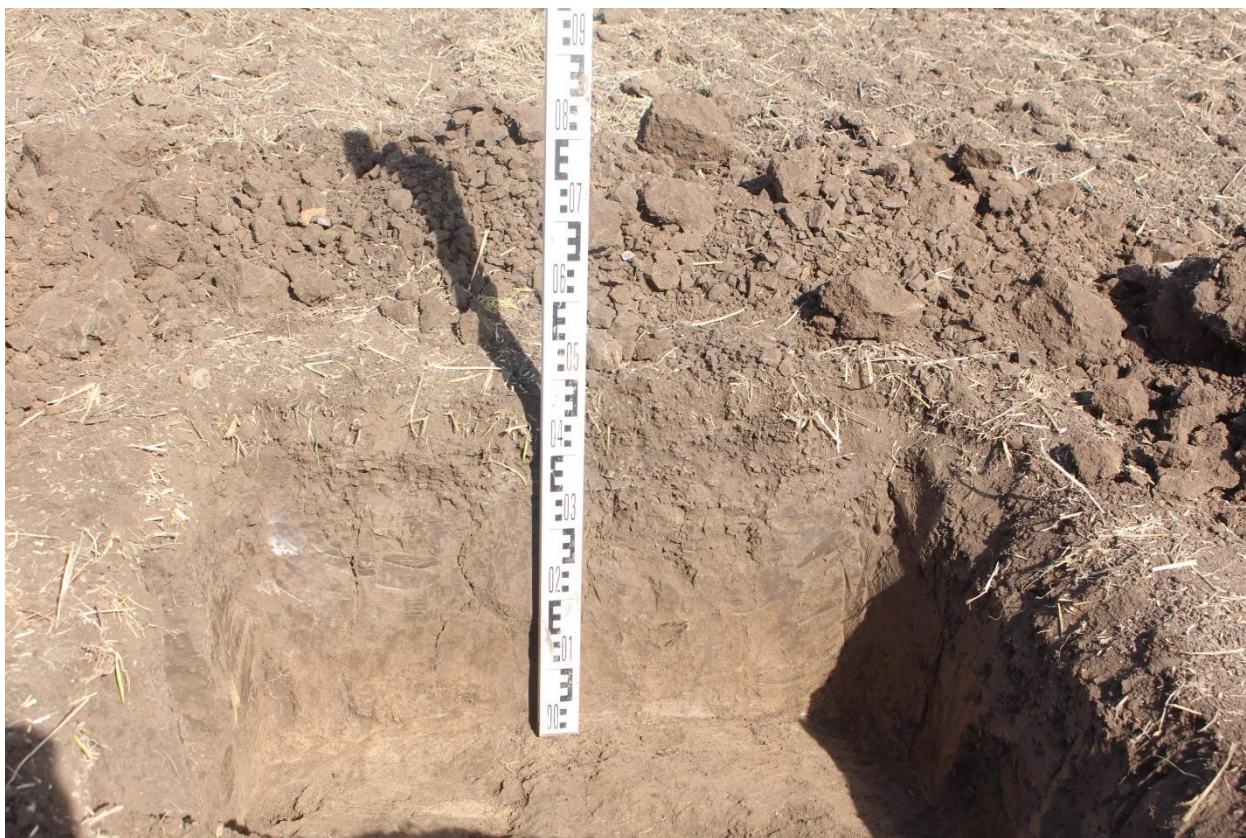
Рис. 128. Херсонская область. Строительство ВЛ 330 кВ Геническая - Мелитопольская. Территория исследований. Шурф 16. Профиль северного борта. Вид с юга.
