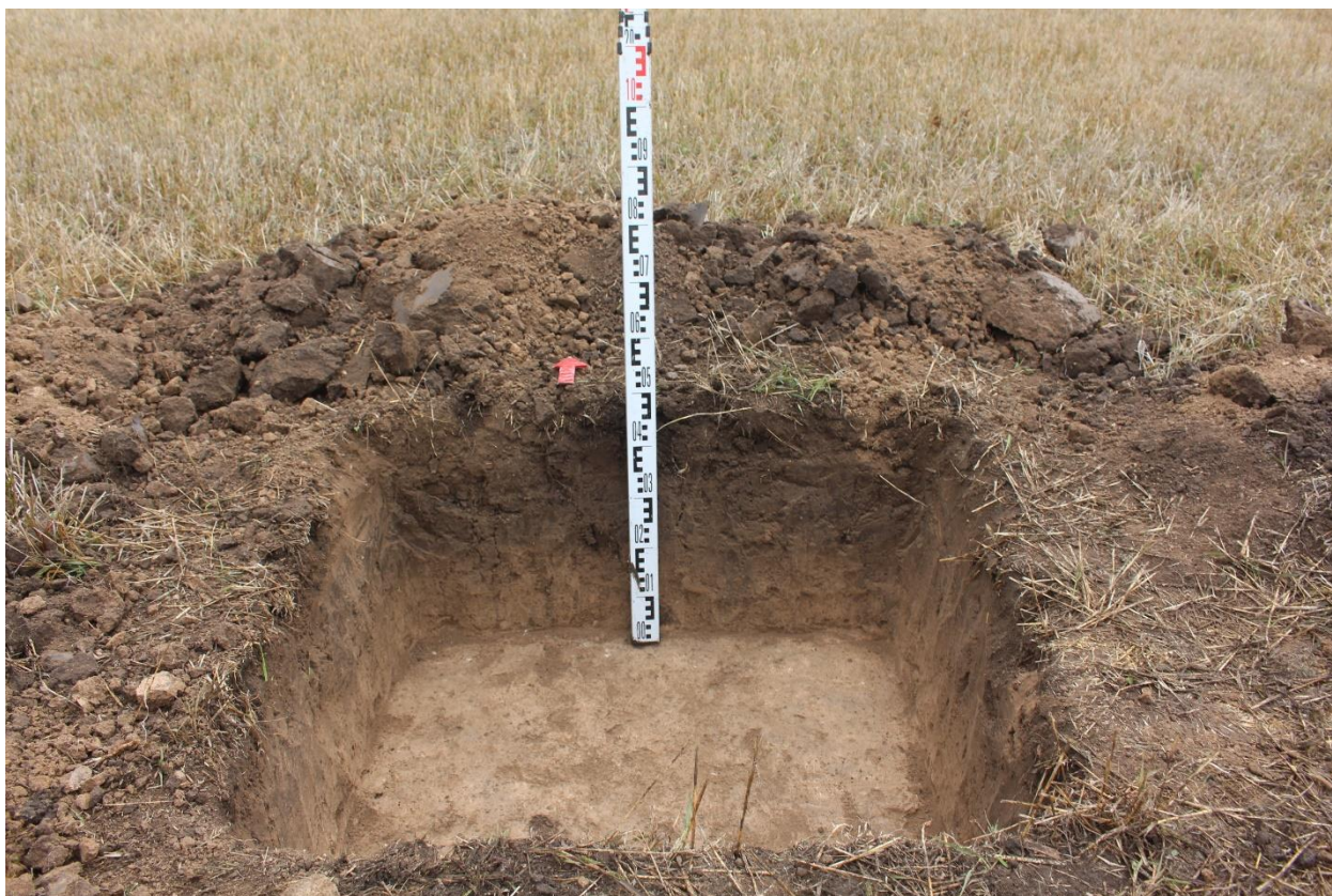
Рис. 92. Херсонская область. Строительство ВЛ 330 кВ Геническая - Мелитопольская. Территория исследований. Шурф 7. Профиль северного борта. Вид с юга.
