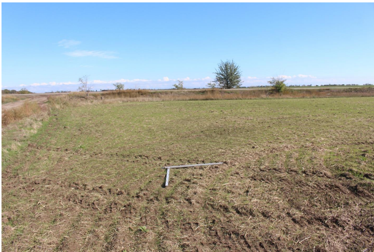
Рис. 110. Херсонская область. Строительство ВЛ 330 кВ Геническая - Мелитопольская. Территория исследований. Шурф 12 до начала работ. Вид с юга.
