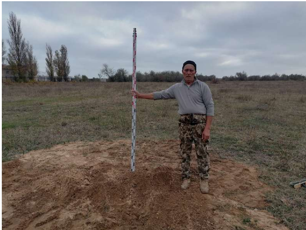
Рис. 76. «Строительство жилого комплекса по адресу: Херсонская область, Генический м.о., Стрелковое с., юго-восточнее ул. Береговой, 12, КН 94:21:8520004:1128». Шурф 6. После окончания работ. Вид с запада.
