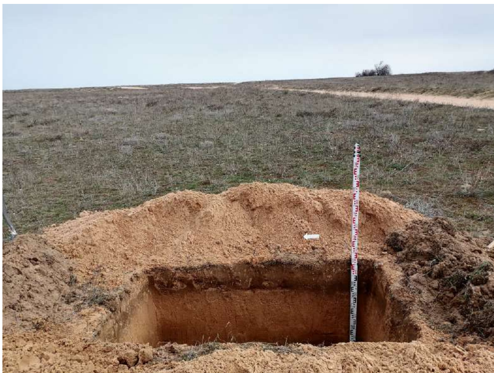
Рис. 135. «Строительство жилого комплекса по адресу: Херсонская область, Генический м.о., Стрелковое с., юго-восточная часть ул. Береговой, КН 94:21:8520004:1126». Шурф 16. Общий вид после прокопки с запада.
