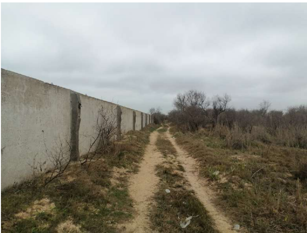
Рис. 19. «Строительство жилого комплекса по адресу: Херсонская область, Генический м.о., Стрелковое с., юго-восточнее ул. Береговой, 12, КН 94:21:8520004:1128». Точка фотофиксации 4. Вид с востока-северо-востока.
