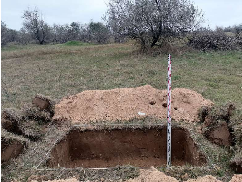
Рис. 50. «Строительство жилого комплекса по адресу: Херсонская область, Генический м.о., Стрелковое с., юго-восточнее ул. Береговой, 12, КН 94:21:8520004:1128». Шурф 1. Общий вид после прокопки с запада.
