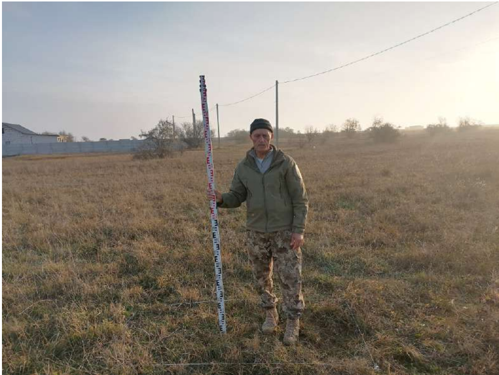
Рис. 187. «Строительство жилого комплекса по адресу: Херсонская область, Генический м.о., Стрелковое с., юго-восточная часть ул. Береговой, КН 94:21:8520004:1126». Шурф 27. До начала работ. Вид с запада.
