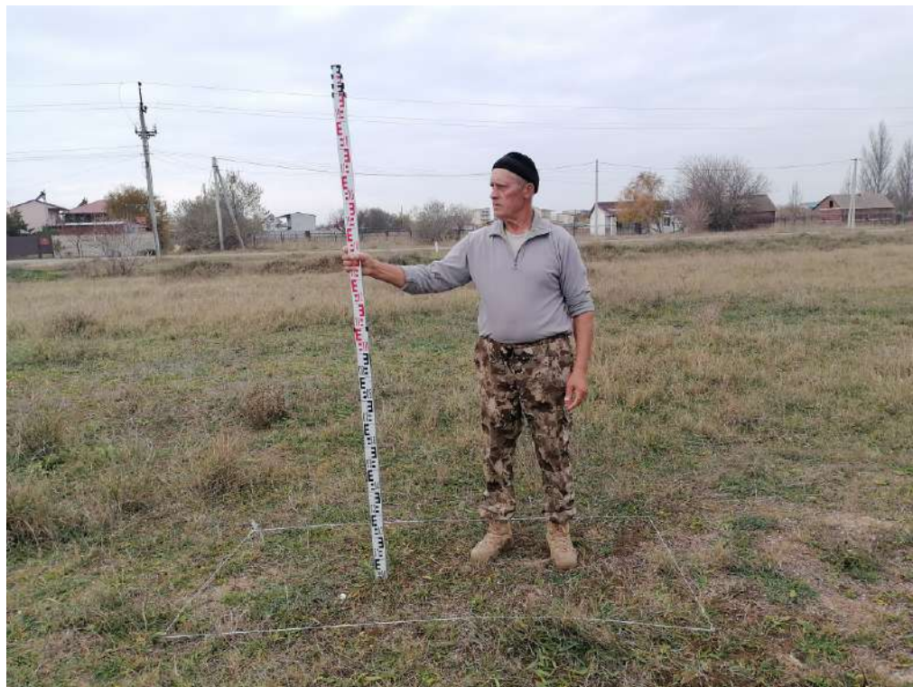
Рис. 162. «Строительство жилого комплекса по адресу: Херсонская область, Генический м.о., Стрелковое с., юго-восточная часть ул. Береговой, КН 94:21:8520004:1126». Шурф 22. До начала работ. Вид с востока.
