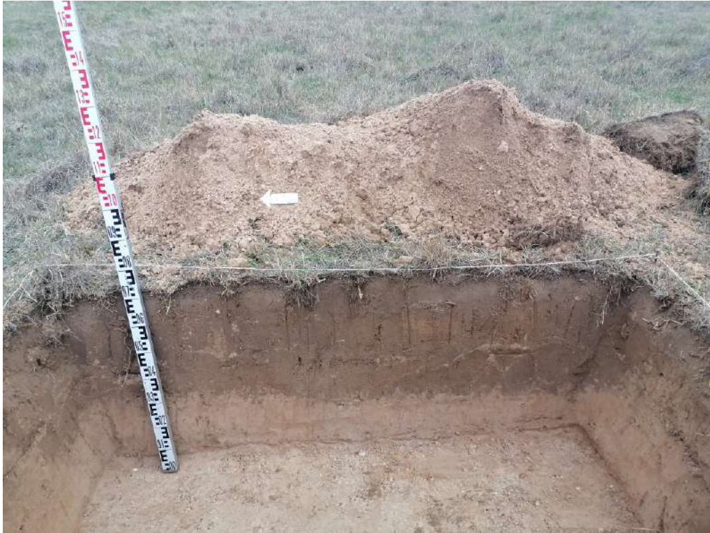
Рис. 69. «Строительство жилого комплекса по адресу: Херсонская область, Генический м.о., Стрелковое с., юго-восточнее ул. Береговой, 12, КН 94:21:8520004:1128». Шурф 5. Восточный борт. Вид с запада.
