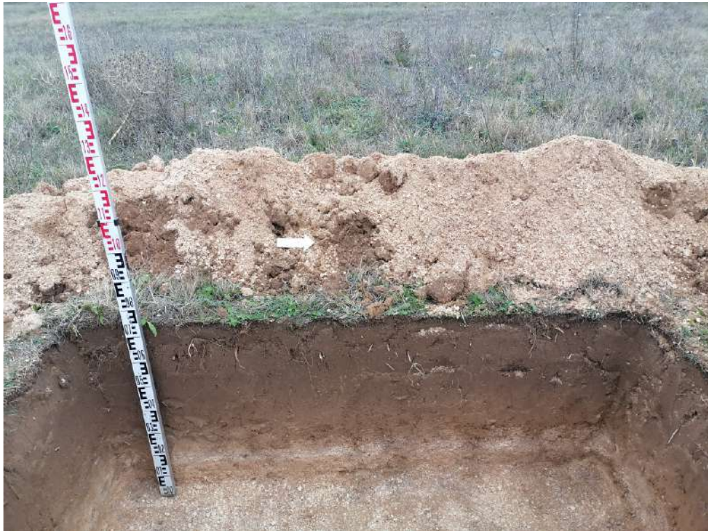
Рис. 79. «Строительство жилого комплекса по адресу: Херсонская область, Генический м.о., Стрелковое с., юго-восточная часть ул. Береговой, КН 94:21:8520004:1126». Шурф 5. Западный борт. Вид с востока.
