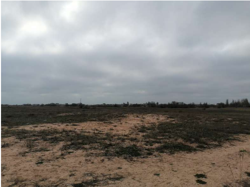
Рис. 34. «Строительство жилого комплекса по адресу: Херсонская область, Генический м.о., Стрелковое с., юго-восточная часть ул. Береговой, КН 94:21:8520004:1126». Точка фотофиксации 7. Вид с северо-северо-востока.
