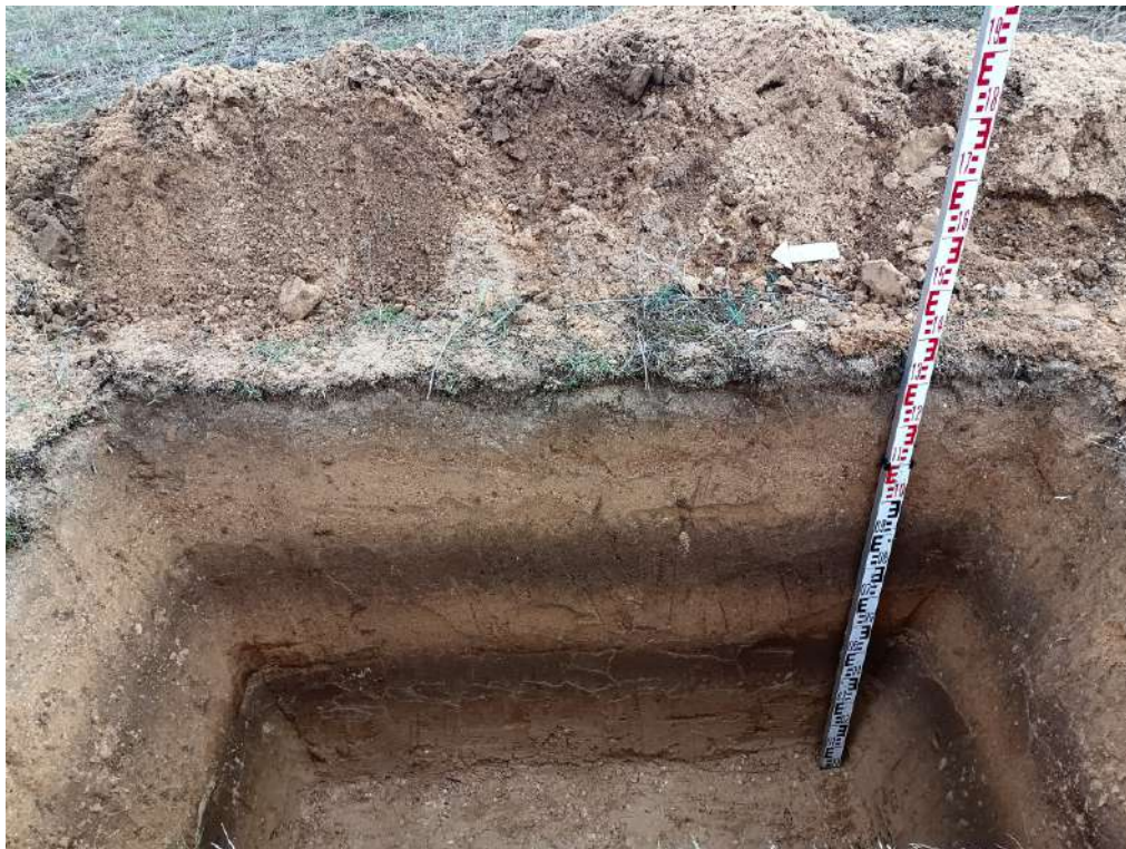
Рис. 139. «Строительство жилого комплекса по адресу: Херсонская область, Генический м.о., Стрелковое с., юго-восточная часть ул. Береговой, КН 94:21:8520004:1126». Шурф 17. Восточный борт. Вид с запада.
