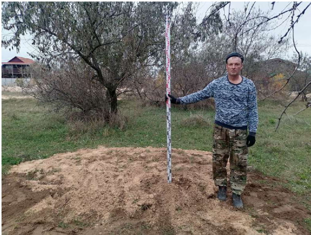
Рис. 56. «Строительство жилого комплекса по адресу: Херсонская область, Генический м.о., Стрелковое с., юго-восточнее ул. Береговой, 12, КН 94:21:8520004:1128». Шурф 2. После окончания работ. Вид с востока.
