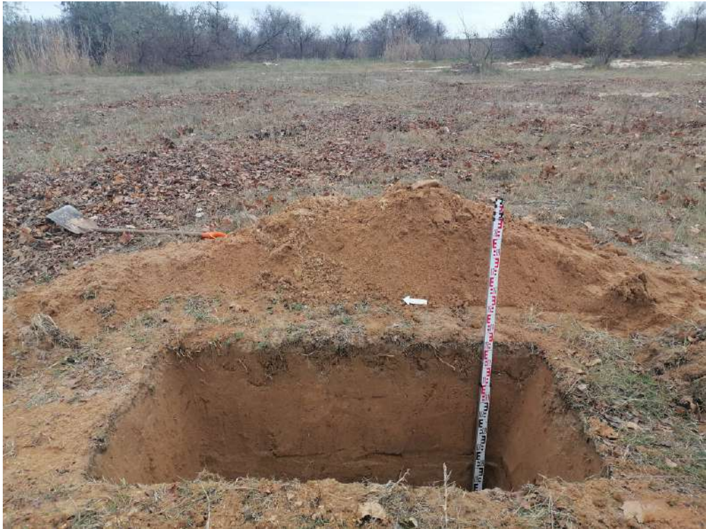
Рис. 95. «Строительство жилого комплекса по адресу: Херсонская область, Генический м.о., Стрелковое с., юго-восточнее ул. Береговой, 12, КН 94:21:8520004:1128». Шурф 10. Общий вид после прокопки с запада.
