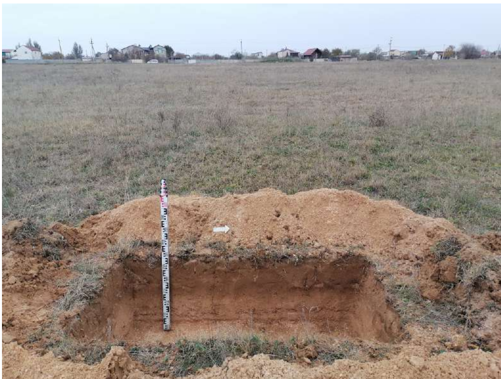
Рис. 155. «Строительство жилого комплекса по адресу: Херсонская область, Генический м.о., Стрелковое с., юго-восточная часть ул. Береговой, КН 94:21:8520004:1126». Шурф 20. Общий вид после прокопки с востока.
