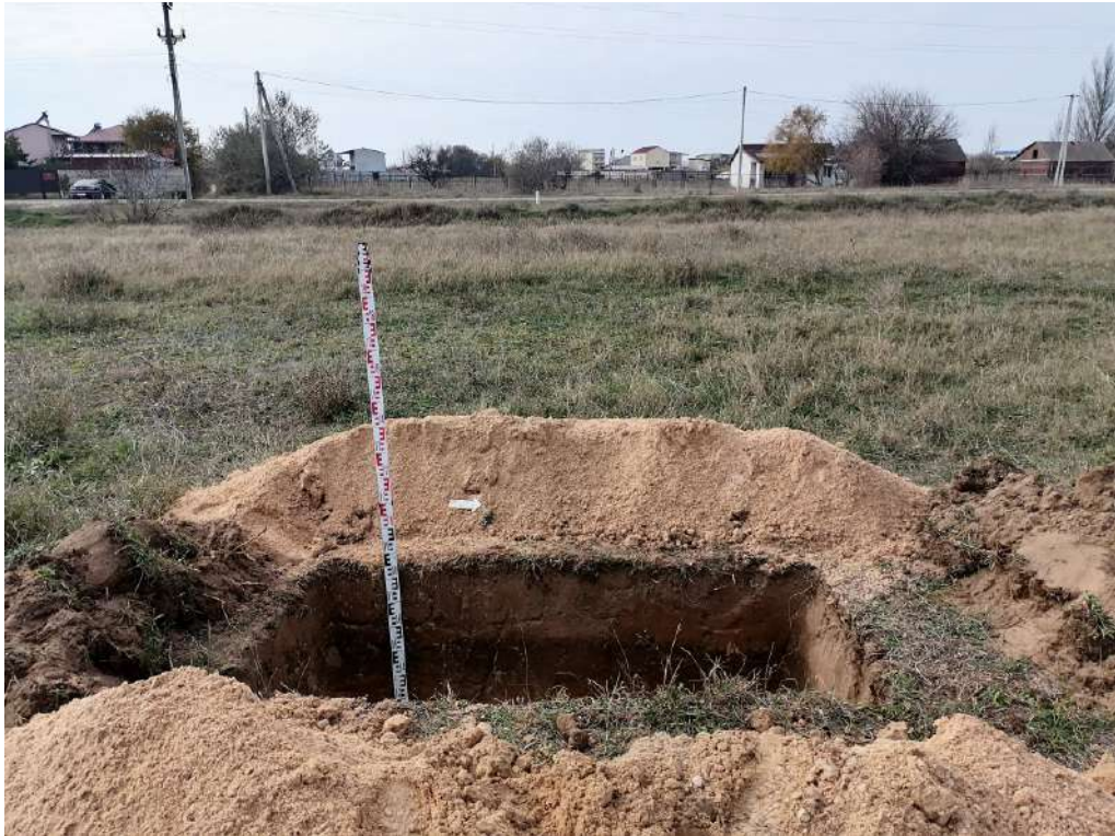
Рис. 165. «Строительство жилого комплекса по адресу: Херсонская область, Генический м.о., Стрелковое с., юго-восточная часть ул. Береговой, КН 94:21:8520004:1126». Шурф 22. Общий вид после прокопки с востока.
