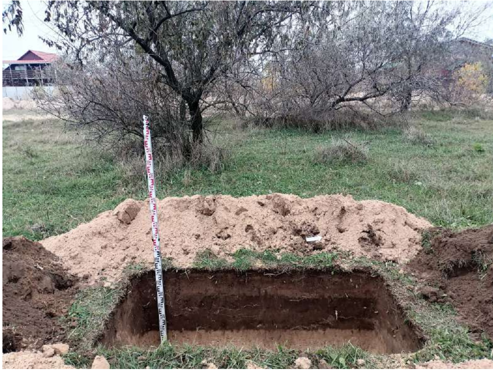
Рис. 55. «Строительство жилого комплекса по адресу: Херсонская область, Генический м.о., Стрелковое с., юго-восточнее ул. Береговой, 12, КН 94:21:8520004:1128». Шурф 2. Общий вид после прокопки с востока.
