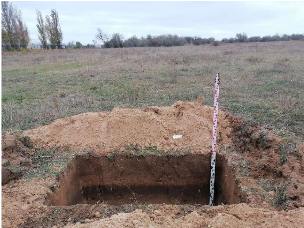
Рис. 75. «Строительство жилого комплекса по адресу: Херсонская область, Генический м.о., Стрелковое с., юго-восточнее ул. Береговой, 12, КН 94:21:8520004:1128». Шурф 6. Общий вид после прокопки с запада.
