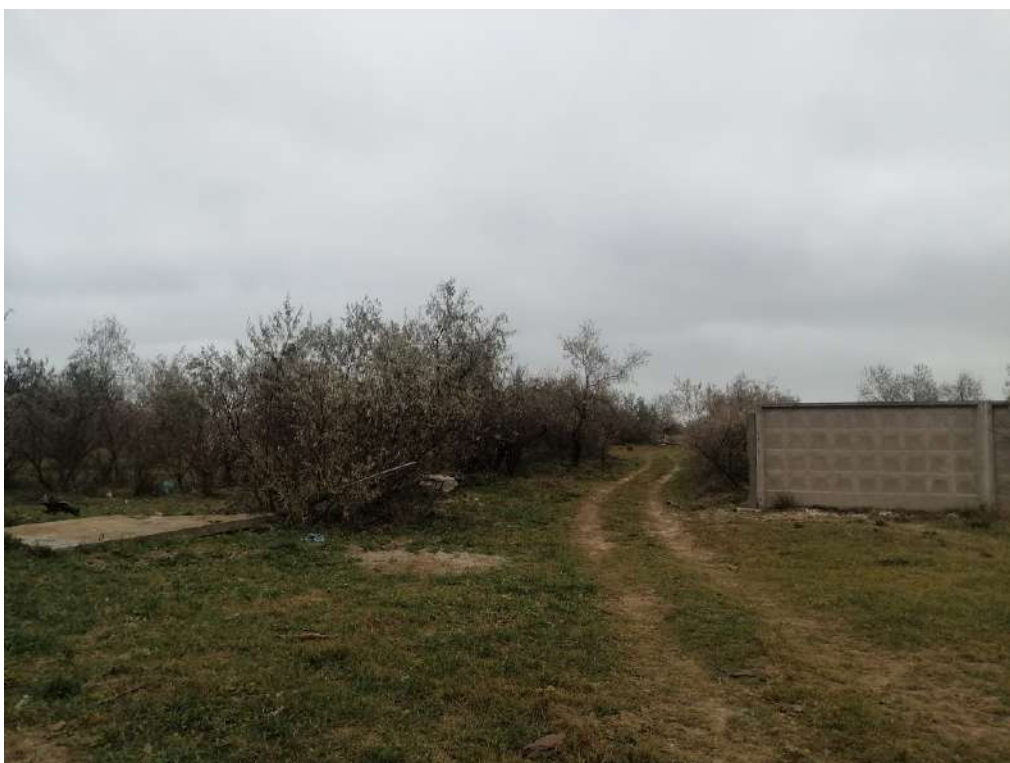
Рис. 11. «Строительство жилого комплекса по адресу: Херсонская область, Генический м.о., Стрелковое с., юго-восточнее ул. Береговой, 12, КН 94:21:8520004:1128». Точка фотофиксации 2. Вид с запада-юго-запада.
