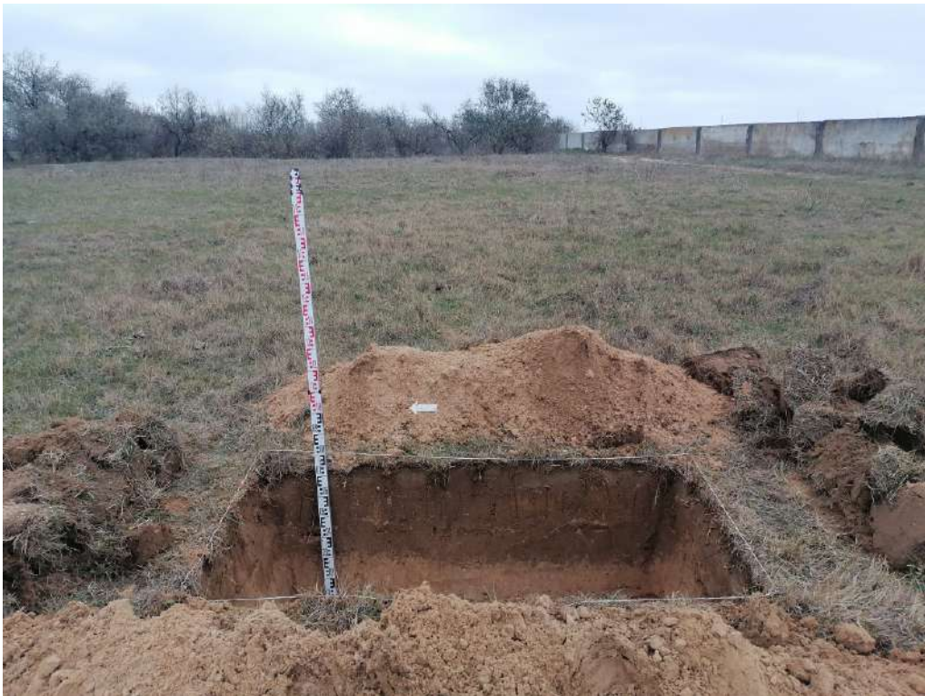
Рис. 70. «Строительство жилого комплекса по адресу: Херсонская область, Генический м.о., Стрелковое с., юго-восточнее ул. Береговой, 12, КН 94:21:8520004:1128». Шурф 5. Общий вид после прокопки с запада.
