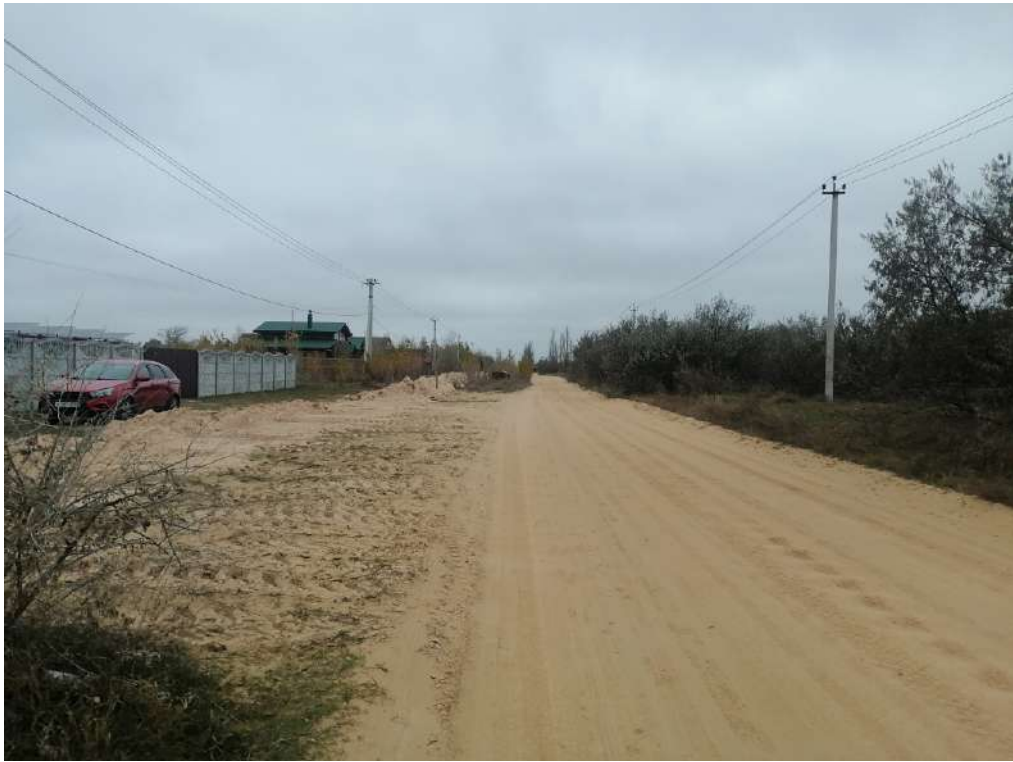
Рис. 12. «Строительство жилого комплекса по адресу: Херсонская область, Генический м.о., Стрелковое с., юго-восточнее ул. Береговой, 12, КН 94:21:8520004:1128». Точка фотофиксации 2. Вид с юго-юго-востока.
