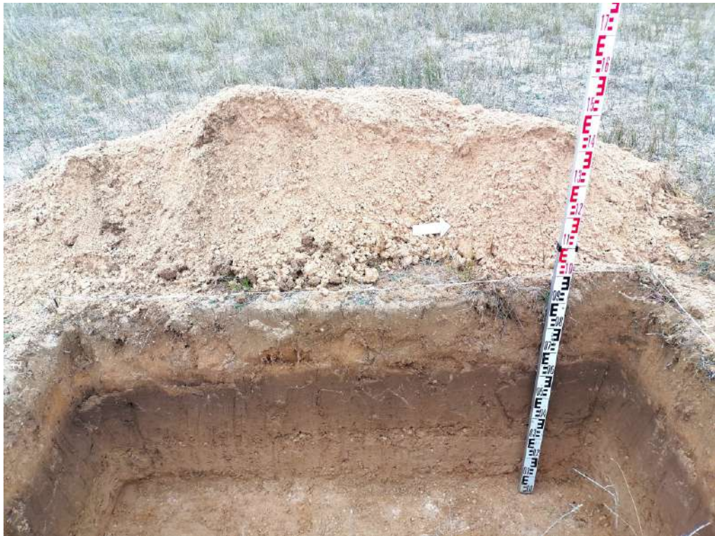
Рис. 99. «Строительство жилого комплекса по адресу: Херсонская область, Генический м.о., Стрелковое с., юго-восточная часть ул. Береговой, КН 94:21:8520004:1126». Шурф 9. Западный борт. Вид с востока.
