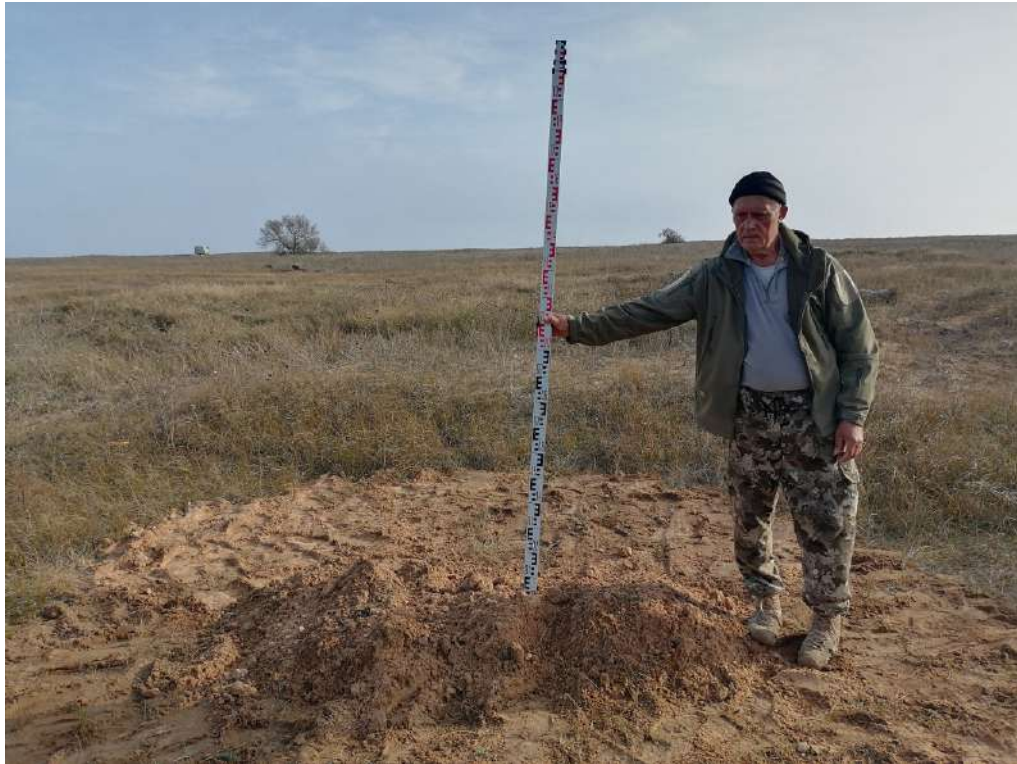
Рис. 211. «Строительство жилого комплекса по адресу: Херсонская область, Генический м.о., Стрелковое с., юго-восточная часть ул. Береговой, КН 94:21:8520004:1126». Шурф 31. После окончания работ. Вид с запада.
