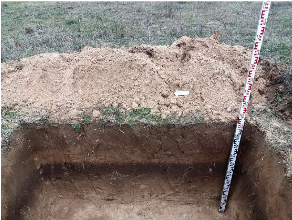
Рис. 74. «Строительство жилого комплекса по адресу: Херсонская область, Генический м.о., Стрелковое с., юго-восточнее ул. Береговой, 12, КН 94:21:8520004:1128». Шурф 6. Восточный борт. Вид с запада.
