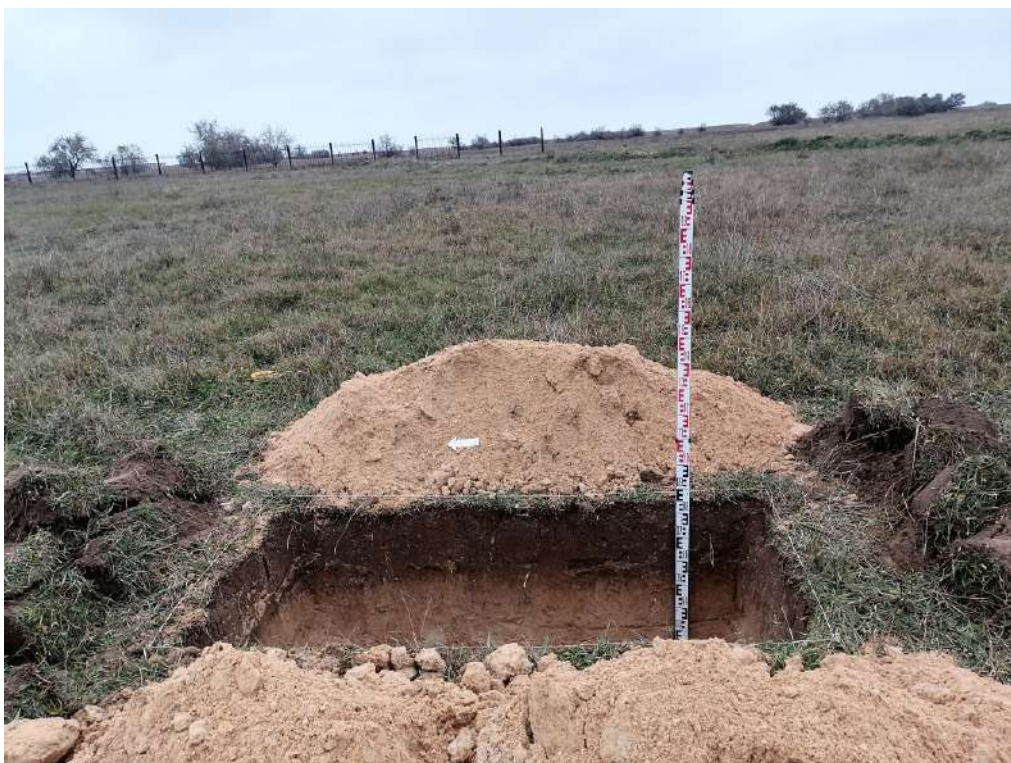
Рис. 70. «Строительство жилого комплекса по адресу: Херсонская область, Генический м.о., Стрелковое с., юго-восточная часть ул. Береговой, КН 94:21:8520004:1126». Шурф 3. Общий вид после прокопки с запада.
