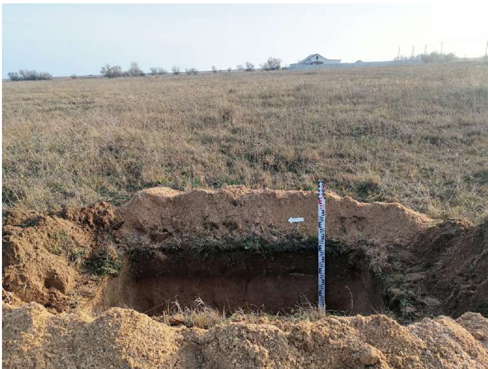
Рис. 185. «Строительство жилого комплекса по адресу: Херсонская область, Генический м.о., Стрелковое с., юго-восточная часть ул. Береговой, КН 94:21:8520004:1126». Шурф 26. Общий вид после прокопки с запада.
