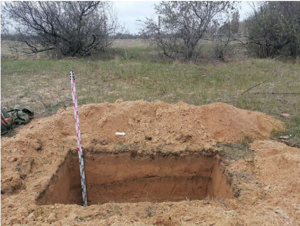
Рис. 90. «Строительство жилого комплекса по адресу: Херсонская область, Генический м.о., Стрелковое с., юго-восточнее ул. Береговой, 12, КН 94:21:8520004:1128». Шурф 9. Общий вид после прокопки с востока.
