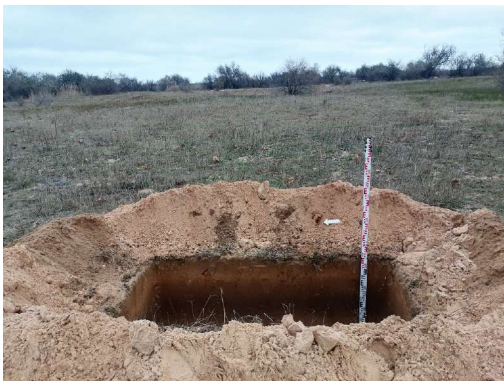
Рис. 80. «Строительство жилого комплекса по адресу: Херсонская область, Генический м.о., Стрелковое с., юго-восточнее ул. Береговой, 12, КН 94:21:8520004:1128». Шурф 7. Общий вид после прокопки с запада.
