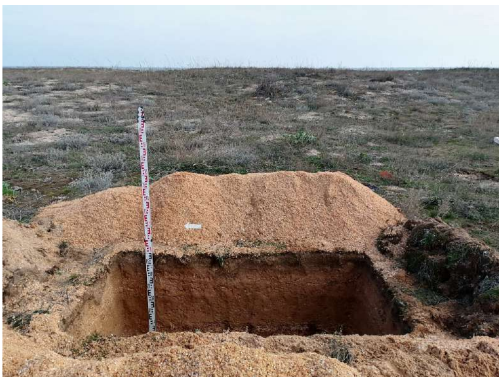
Рис. 220. «Строительство жилого комплекса по адресу: Херсонская область, Генический м.о., Стрелковое с., юго-восточная часть ул. Береговой, КН 94:21:8520004:1126». Шурф 33. Общий вид после прокопки с запада.
