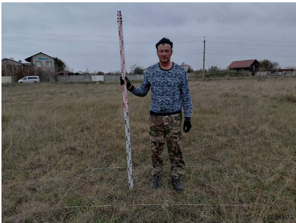
Рис. 167. «Строительство жилого комплекса по адресу: Херсонская область, Генический м.о., Стрелковое с., юго-восточная часть ул. Береговой, КН 94:21:8520004:1126». Шурф 23. До начала работ. Вид с востока.
