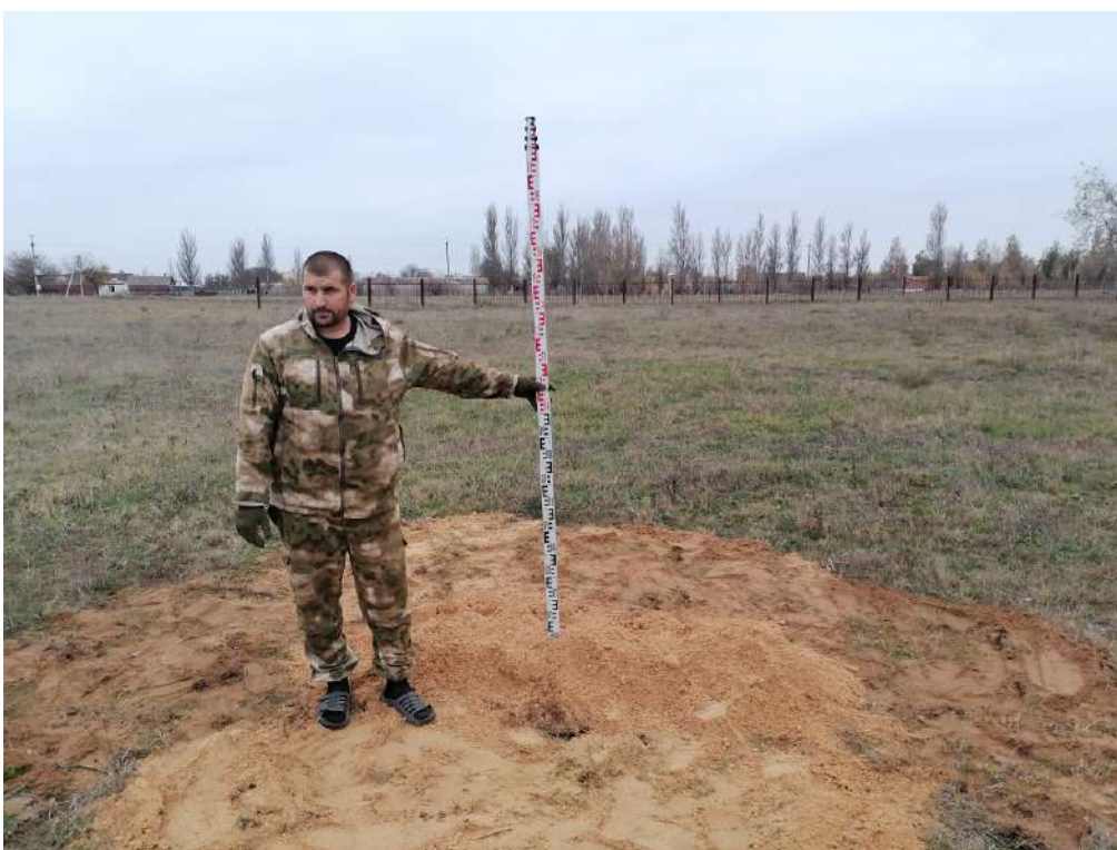
Рис. 86. «Строительство жилого комплекса по адресу: Херсонская область, Генический м.о., Стрелковое с., юго-восточная часть ул. Береговой, КН 94:21:8520004:1126». Шурф 6. После окончания работ. Вид с востока.
