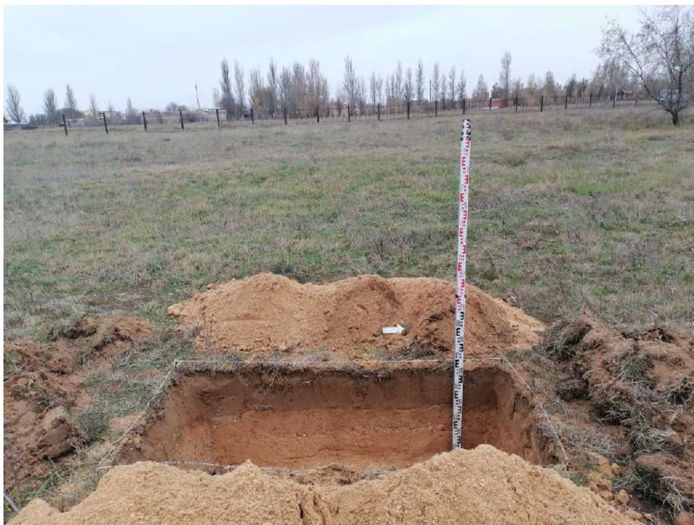
Рис. 85. «Строительство жилого комплекса по адресу: Херсонская область, Генический м.о., Стрелковое с., юго-восточная часть ул. Береговой, КН 94:21:8520004:1126». Шурф 6. Общий вид после прокопки с востока.
