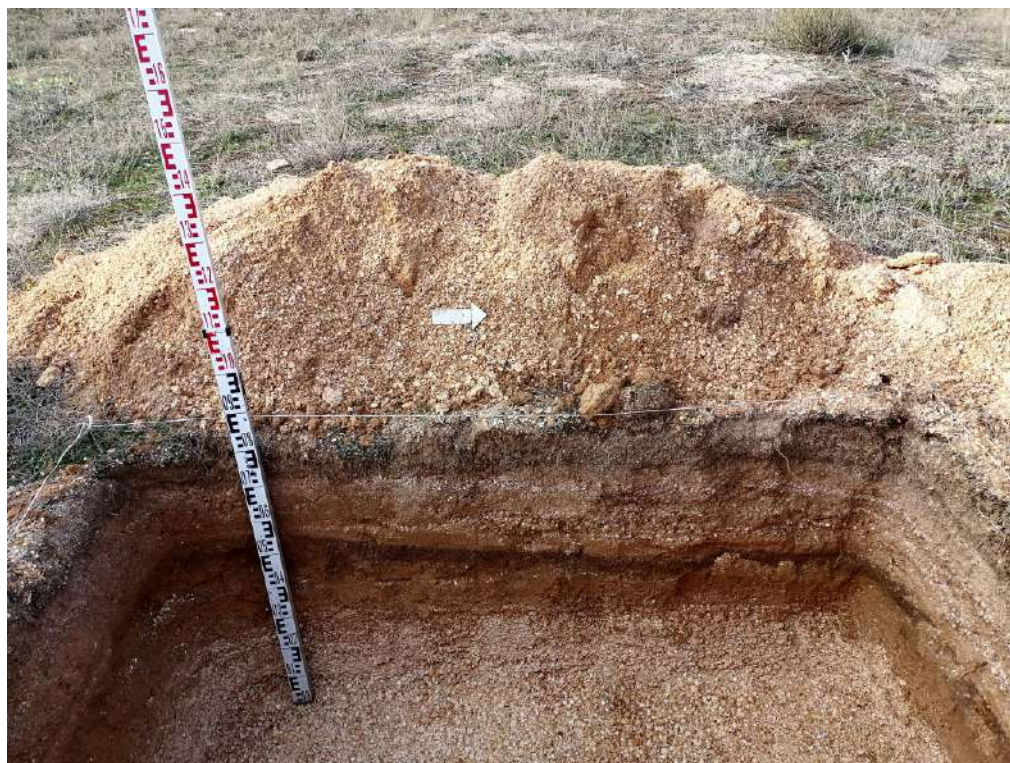
Рис. 214. «Строительство жилого комплекса по адресу: Херсонская область, Генический м.о., Стрелковое с., юго-восточная часть ул. Береговой, КН 94:21:8520004:1126». Шурф 32. Западный борт. Вид с востока.
