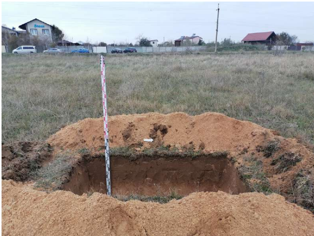
Рис. 170. «Строительство жилого комплекса по адресу: Херсонская область, Генический м.о., Стрелковое с., юго-восточная часть ул. Береговой, КН 94:21:8520004:1126». Шурф 23. Общий вид после прокопки с востока.
