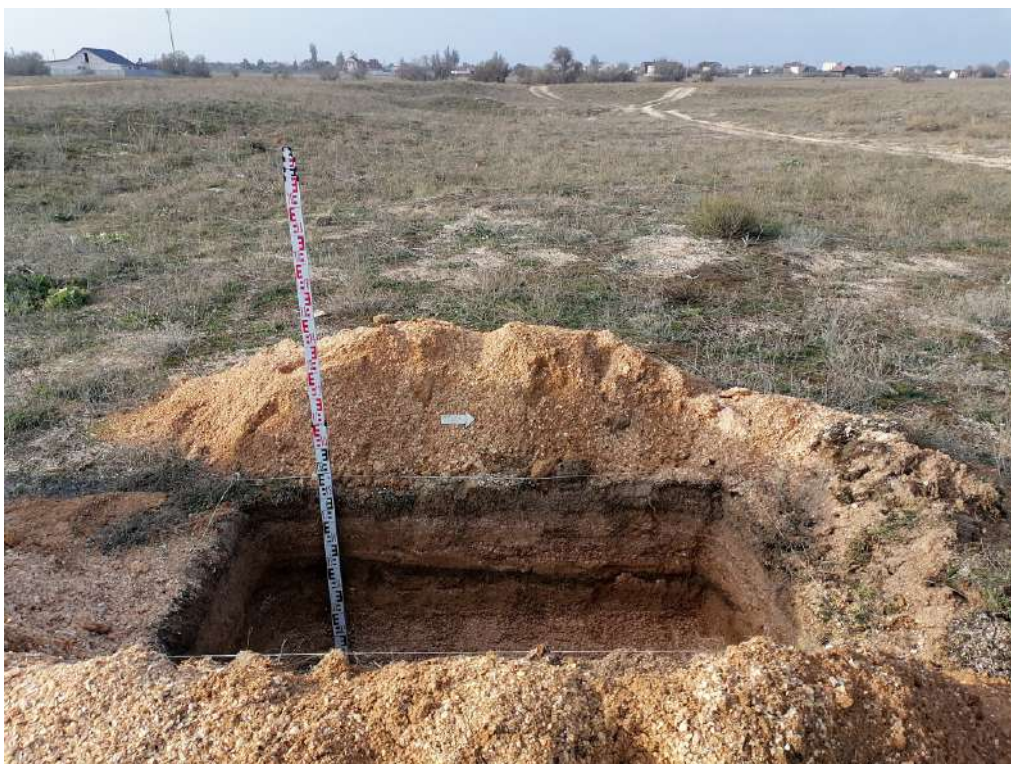
Рис. 215. «Строительство жилого комплекса по адресу: Херсонская область, Генический м.о., Стрелковое с., юго-восточная часть ул. Береговой, КН 94:21:8520004:1126». Шурф 32. Общий вид после прокопки с востока.
