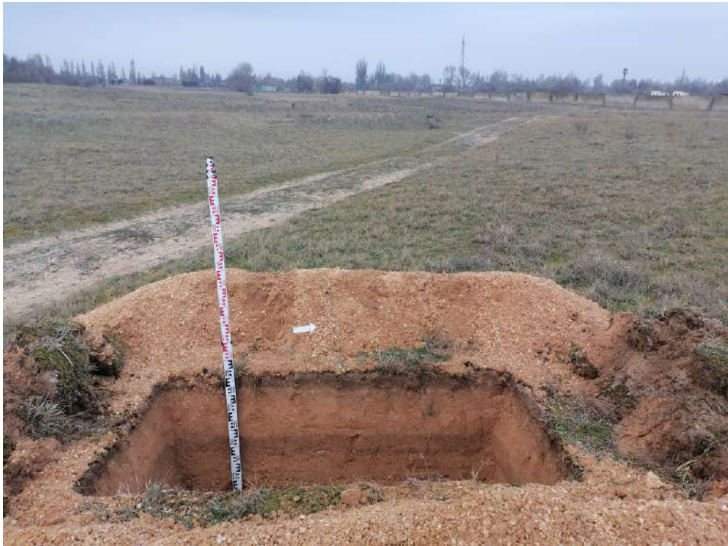
Рис. 105. «Строительство жилого комплекса по адресу: Херсонская область, Генический м.о., Стрелковое с., юго-восточная часть ул. Береговой, КН 94:21:8520004:1126». Шурф 10. Общий вид после прокопки с востока.
