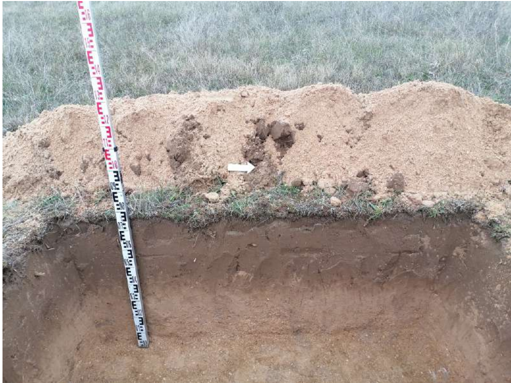
Рис. 169. «Строительство жилого комплекса по адресу: Херсонская область, Генический м.о., Стрелковое с., юго-восточная часть ул. Береговой, КН 94:21:8520004:1126». Шурф 23. Западный борт. Вид с востока.
