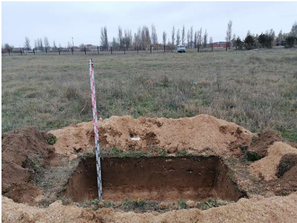
Рис. 80. «Строительство жилого комплекса по адресу: Херсонская область, Генический м.о., Стрелковое с., юго-восточная часть ул. Береговой, КН 94:21:8520004:1126». Шурф 5. Общий вид после прокопки с востока.
