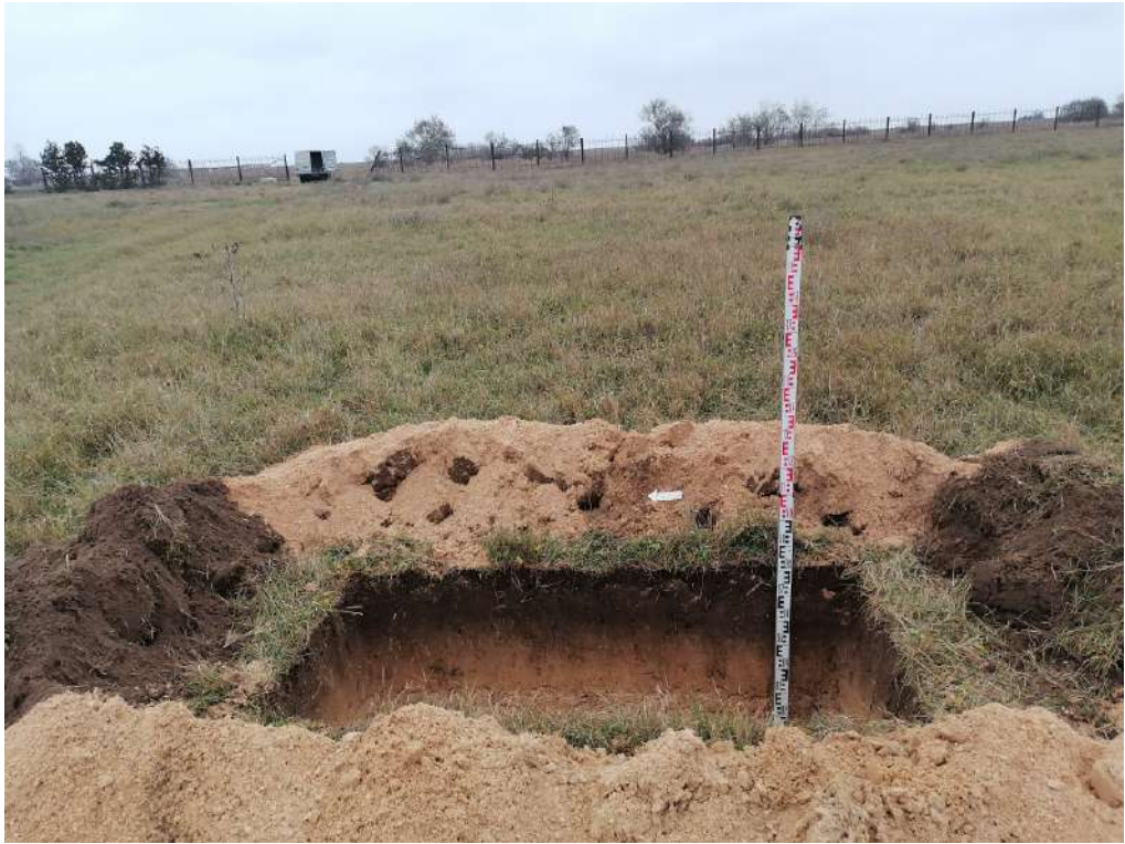
Рис. 65. «Строительство жилого комплекса по адресу: Херсонская область, Генический м.о., Стрелковое с., юго-восточная часть ул. Береговой, КН 94:21:8520004:1126». Шурф 2. Общий вид после прокопки с запада.
