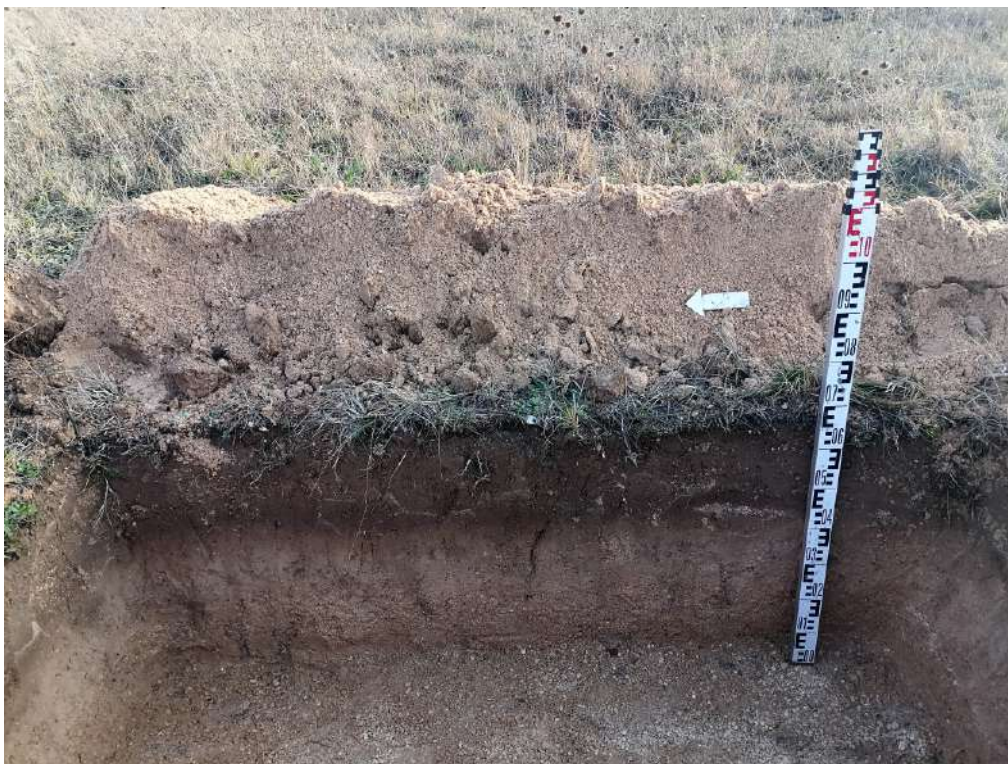
Рис. 184. «Строительство жилого комплекса по адресу: Херсонская область, Генический м.о., Стрелковое с., юго-восточная часть ул. Береговой, КН 94:21:8520004:1126». Шурф 26. Восточный борт. Вид с запада.
