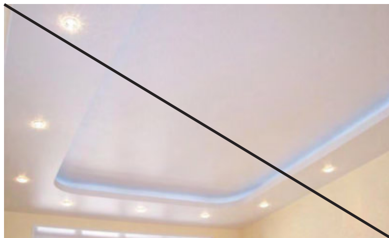
Плохо Многоуровневые гипсокартонные конструкции
