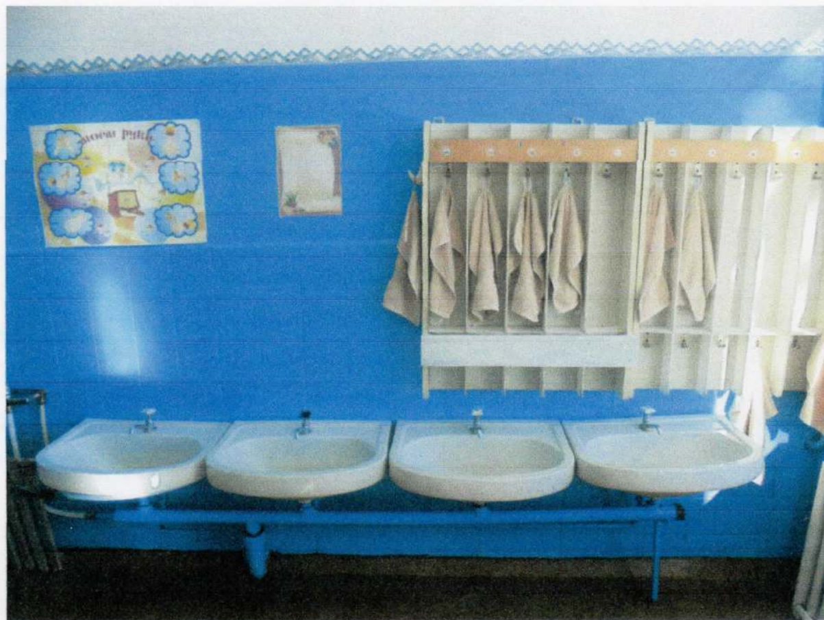
Фото 39. п. 5.1 Туалетная комната
